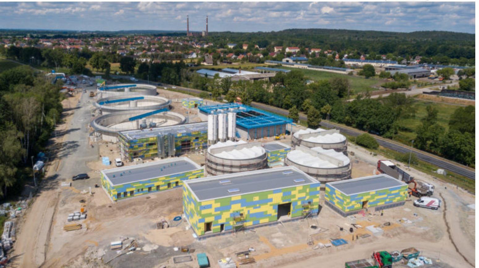
Im Bau befindliche LMBV-Wasserbehandlungsanlage Plessa (2022)
