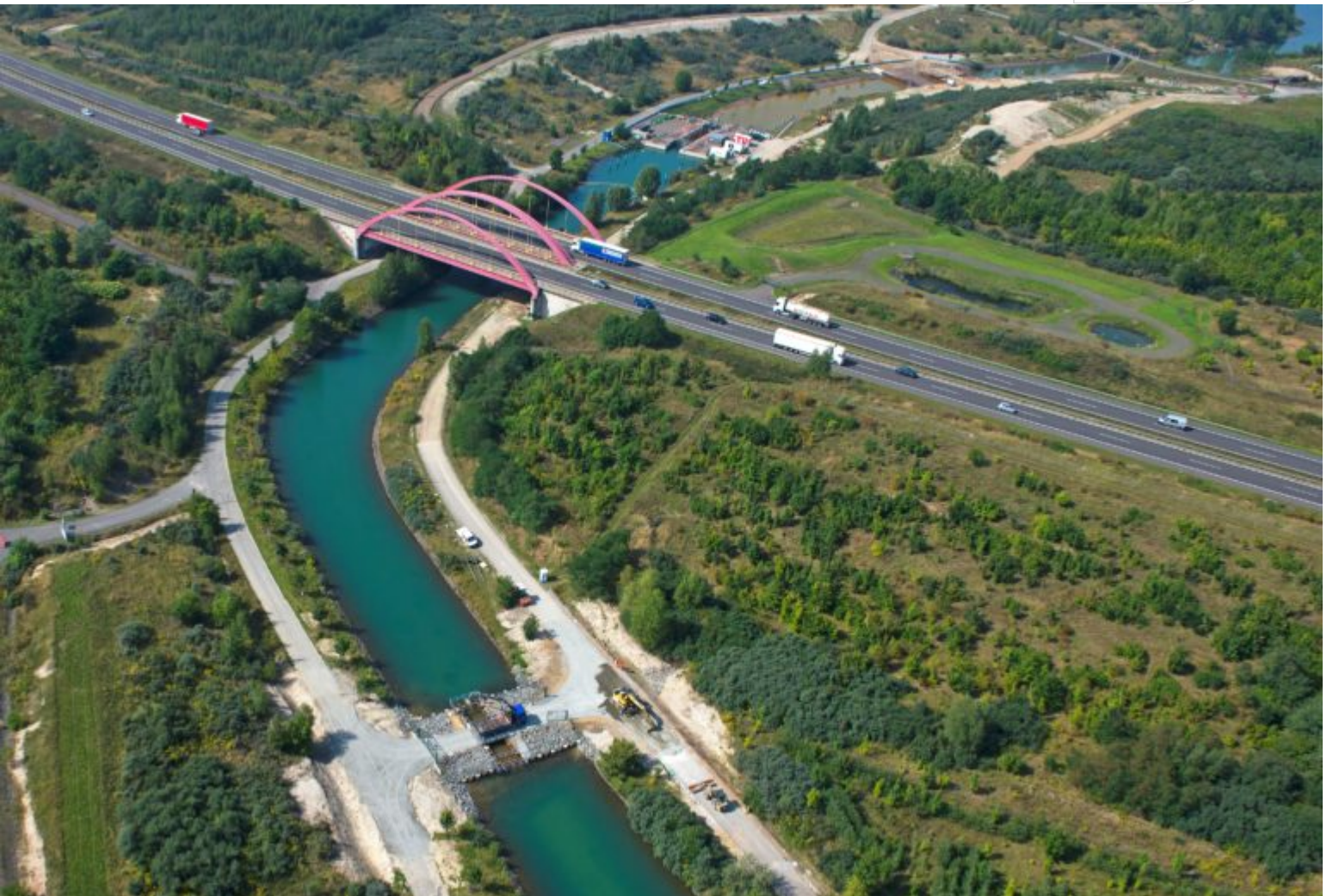
Sofortmaßnahmen zur Gefahrenabwehr - Errichtung von zwei Querbauwerken ober- und unterhalb der Schleuse, September 2021, (Foto: Ch. Bedeschinski).
