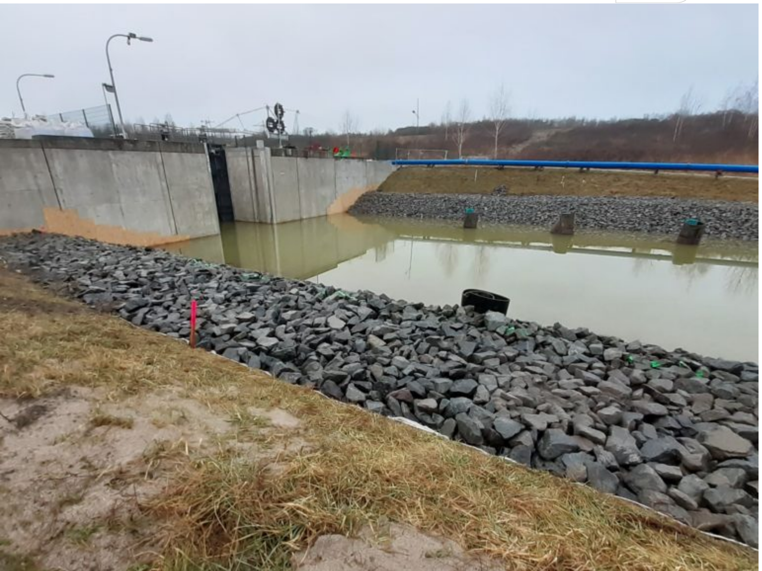
Befestigung der Böschung unterhalb der Kanuparkschleuse mit Wasserbausteinen, im Hintergrund die blaue Heberleitung, Januar 2022, (Foto: LMBV).
