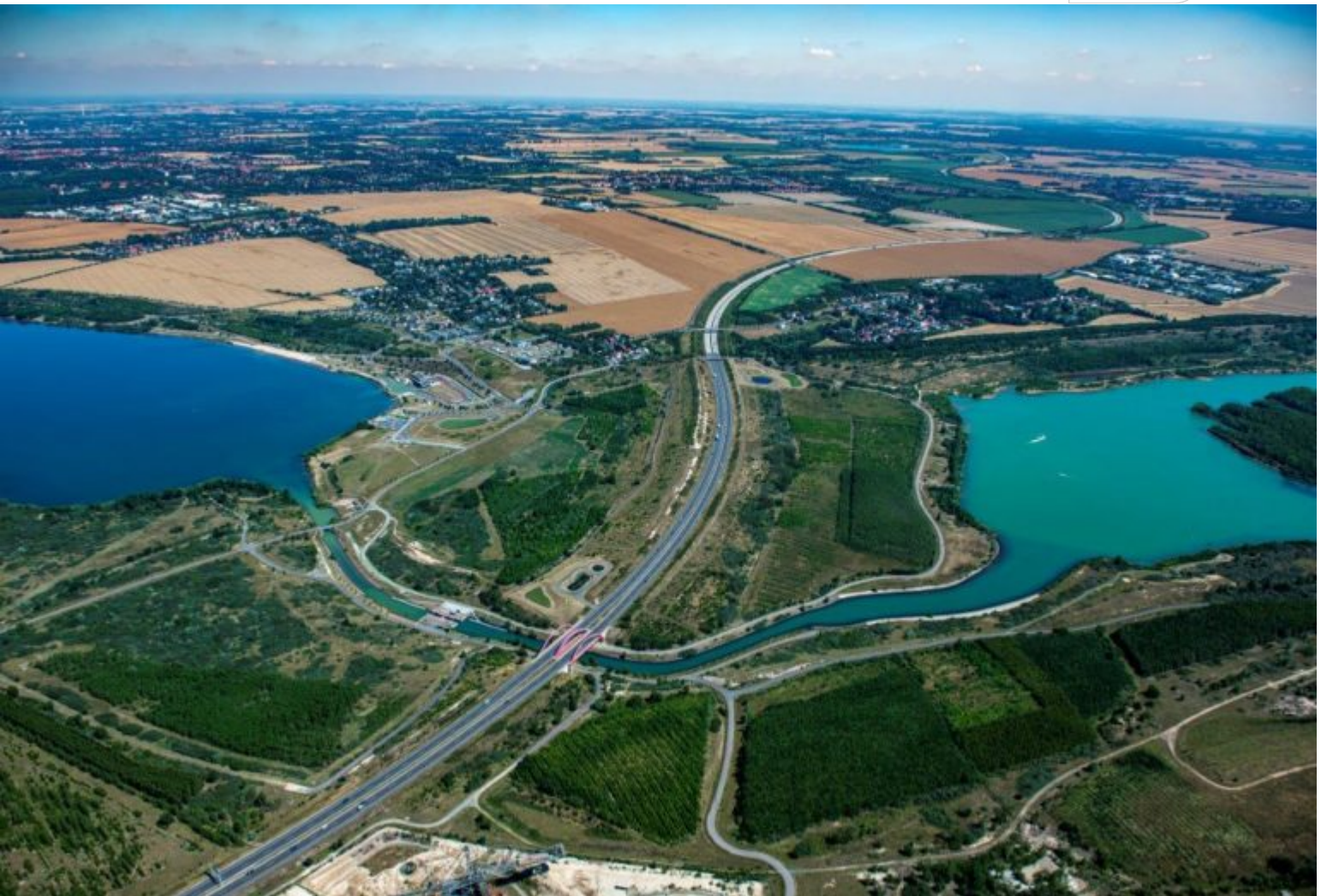
Der Störnthaler Kanal mit A 38 und Kanuparkschleuse zwischen Störnthaler (rechts) und Markkleeberger See (links), 2019, (Foto: P. Radke).
