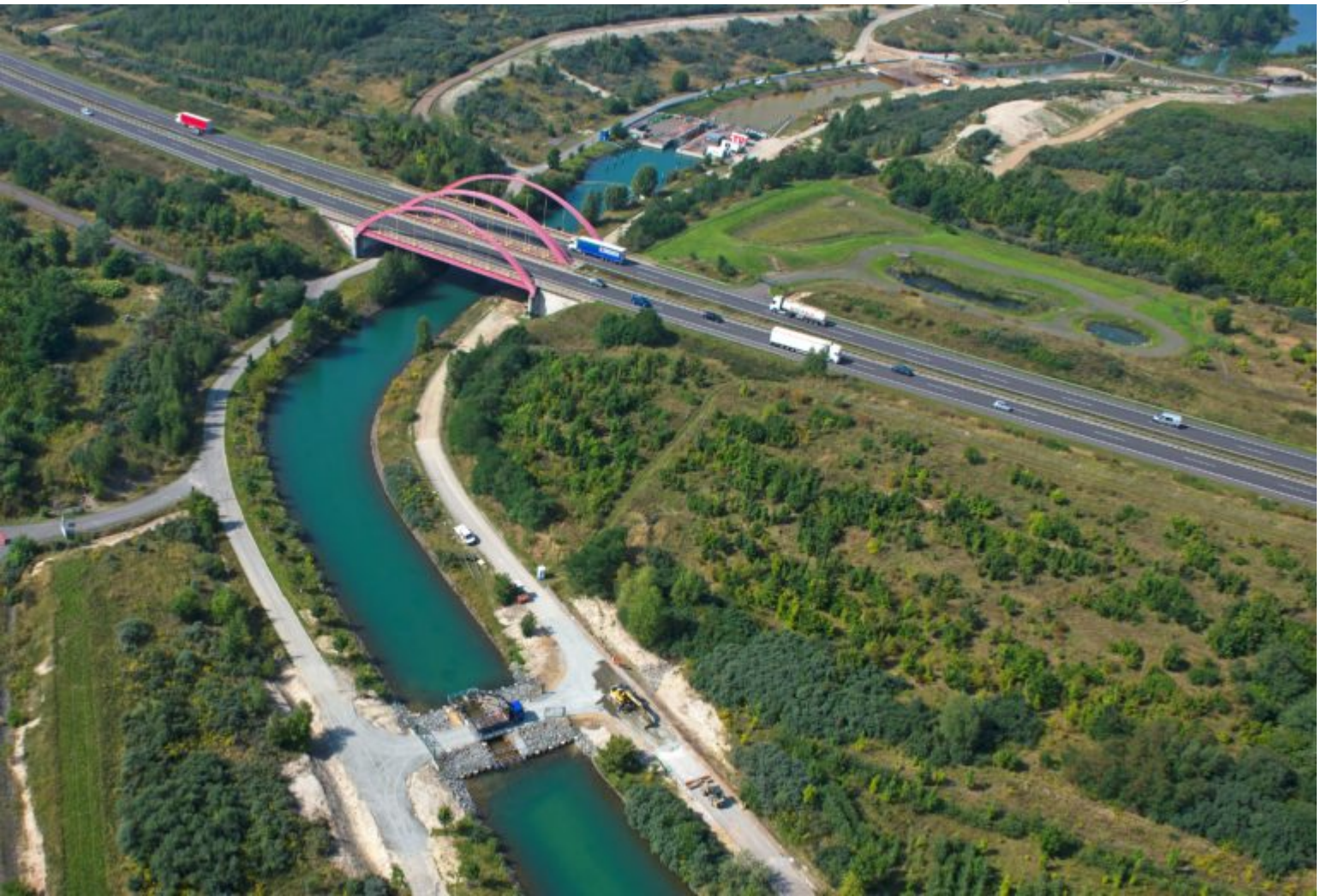
Sofortmaßnahmen zur Gefahrenabwehr - Errichtung von zwei Querbauwerken ober- und unterhalb der Schleuse, September 2021, (Foto: Ch. Bedeschinski).
