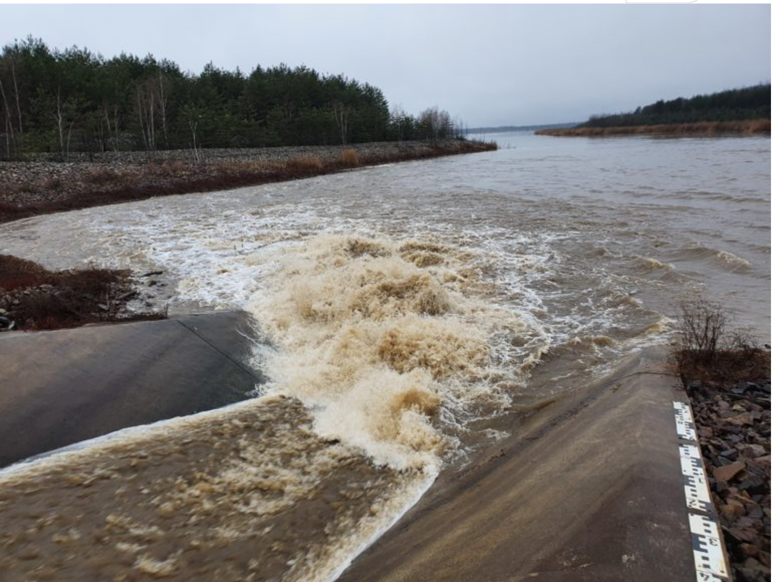
Absturzrampe ins Speicherbecken Lohsa II - Spreewasser schießt mit 6,2 \text{ m}^3/\text{s} ein
