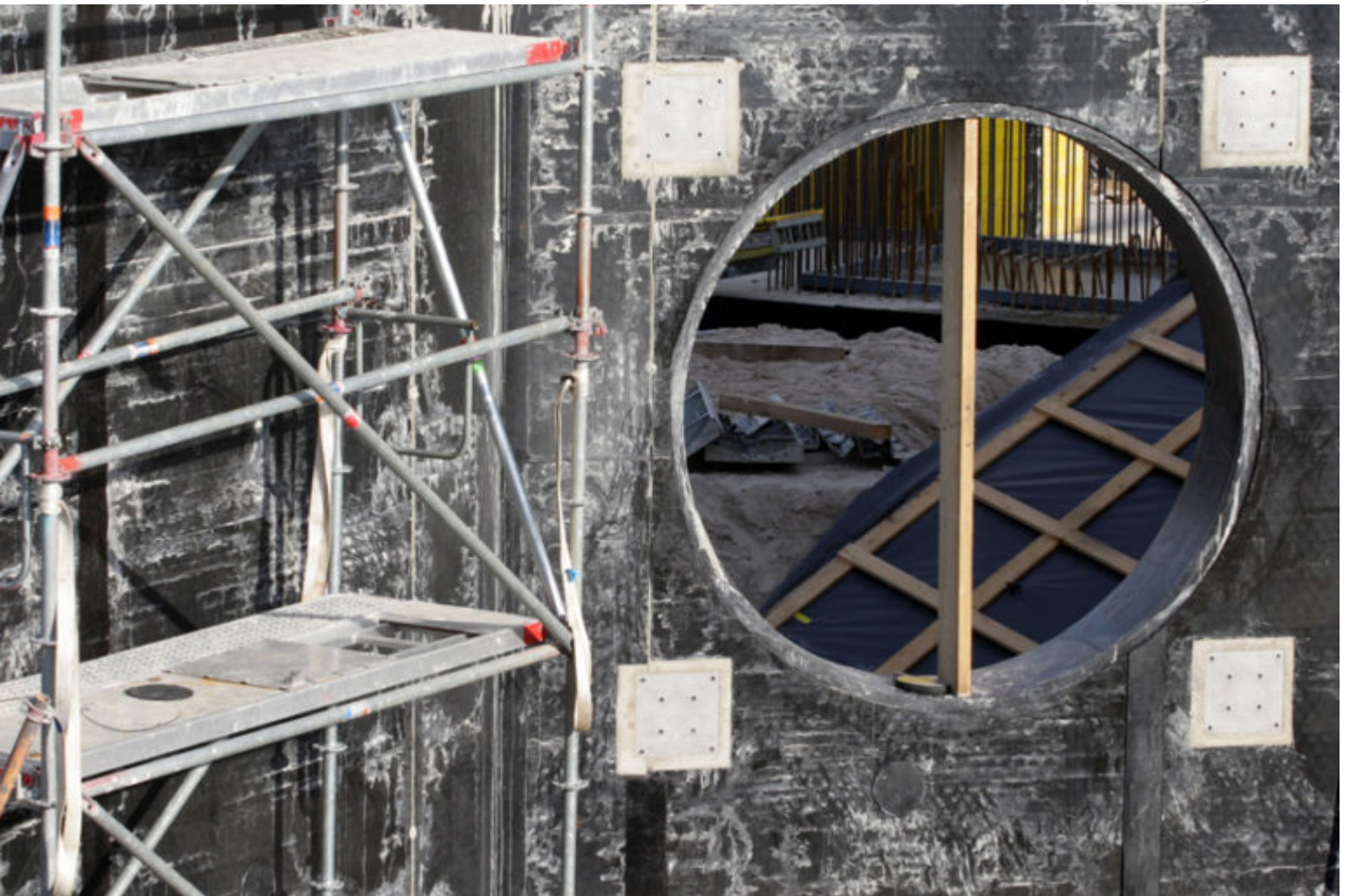
Durchlass für die künftige Rohwasserleitung
