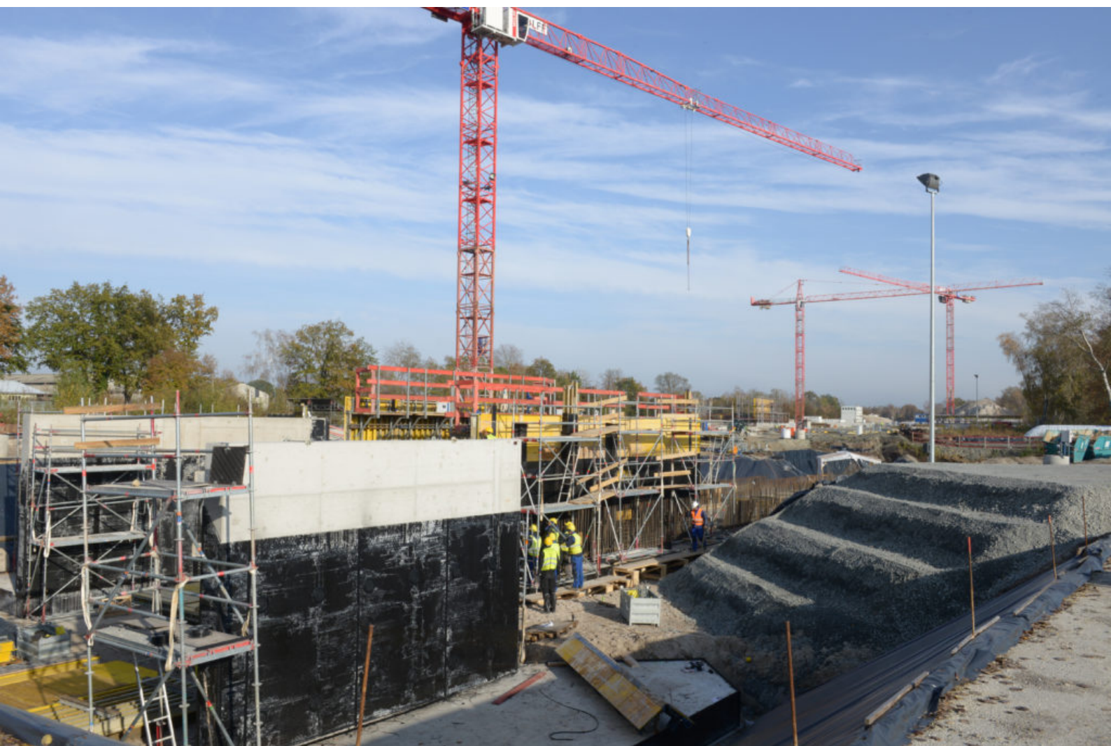
Plessa LMBV-Baustelle WBA Plessa
