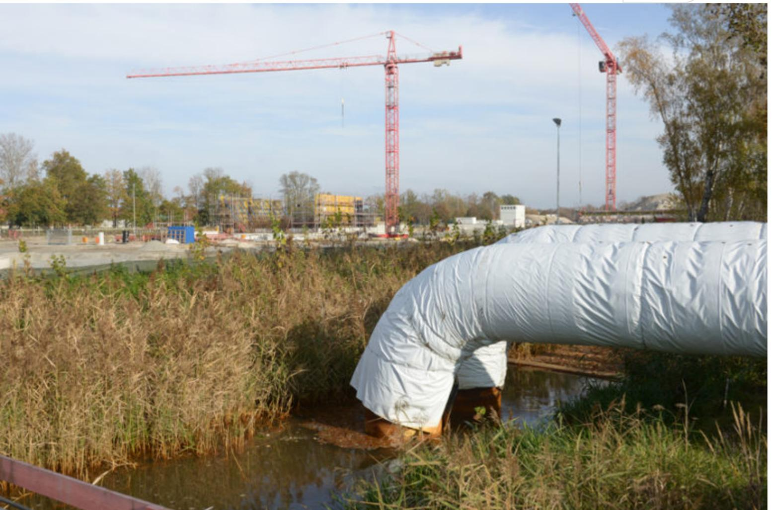
Während des Baus wird der Hammergraben umgeleitet.
