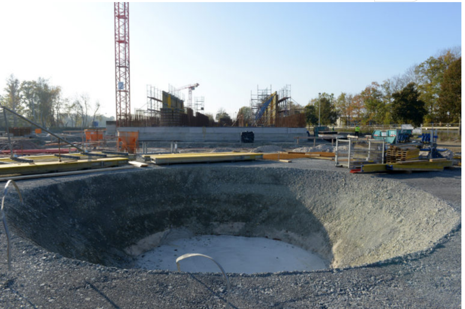
Im Hintergrund des Sedimentationsbeckens entsteht das Maschinenhaus.
