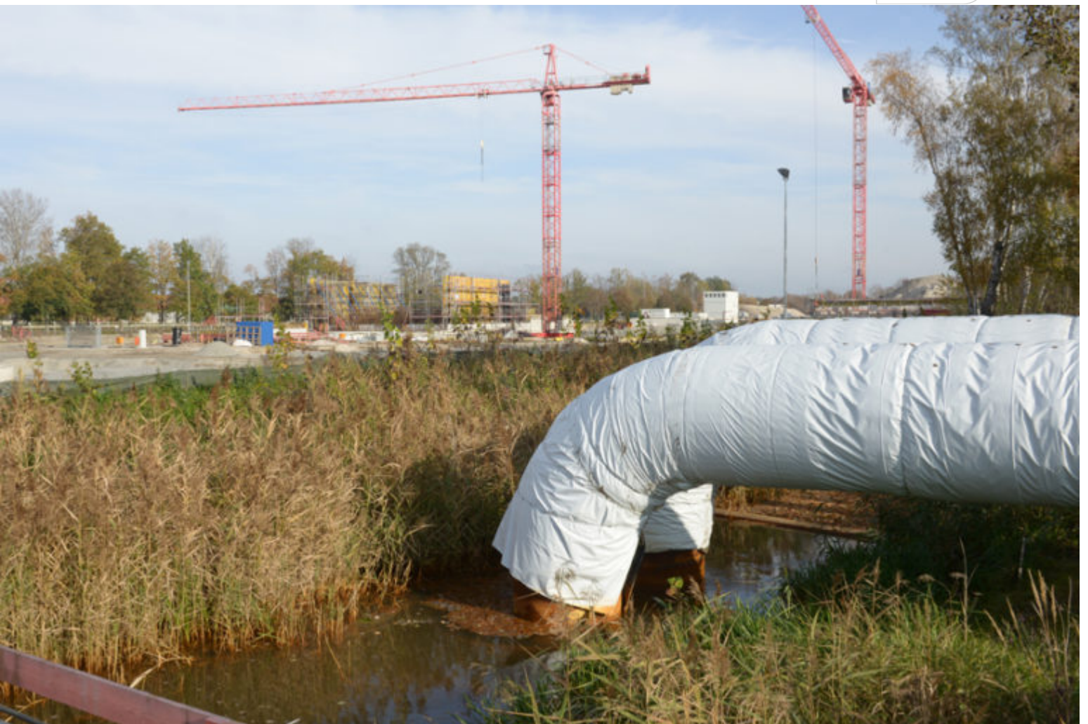
Während des Baus wird der Hammergraben umgeleitet.
