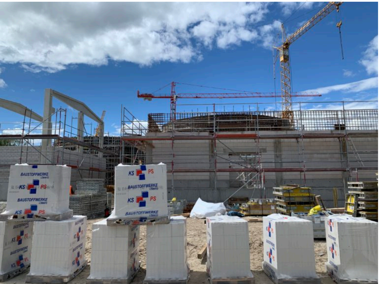
Blick auf die Baustelle
