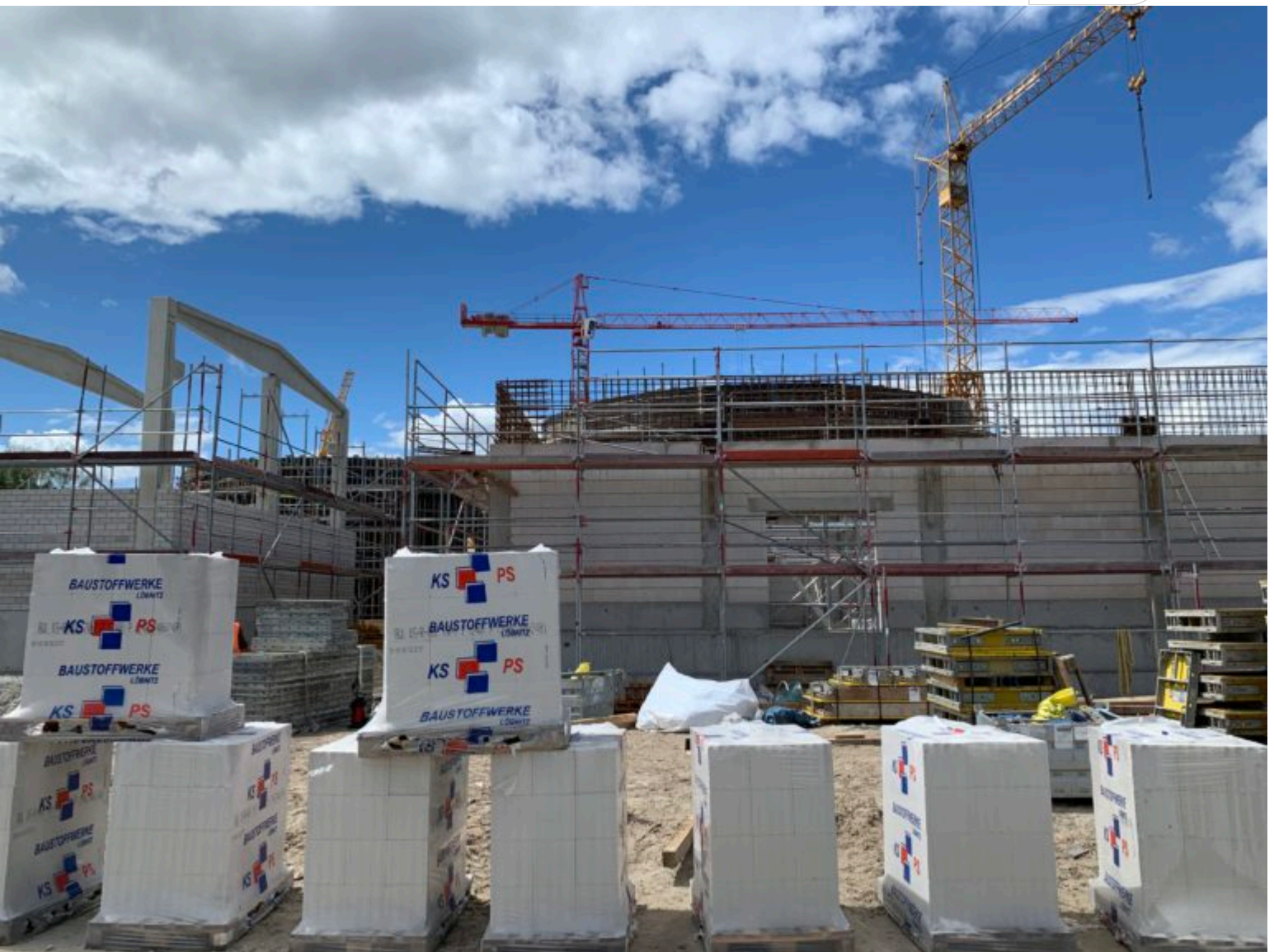
Blick auf die Baustelle
