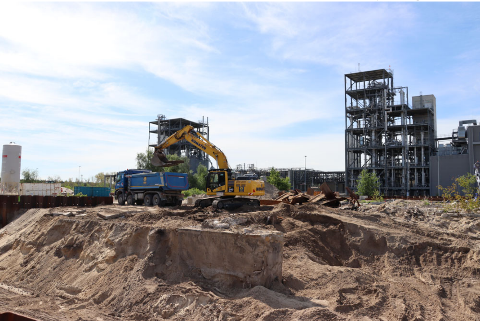
Voraushub im Bereich der Destillation Impressionen von den Arbeiten im Industriepark Schwarze Pumpe
