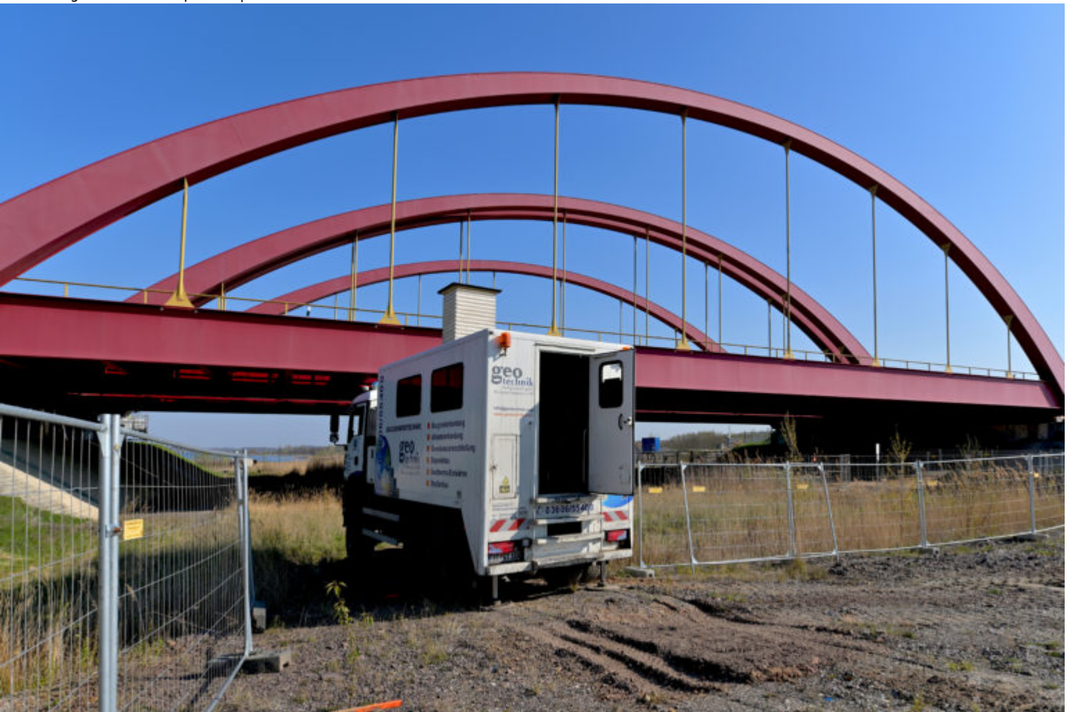
Bodenbeschaffenheitsprüfung durch die Geotechnik Heiligenstadt GmbH auf der Baustelle Harthkanal am Zwenkauer See Foto aus 2019 | C. Bedeschinski
