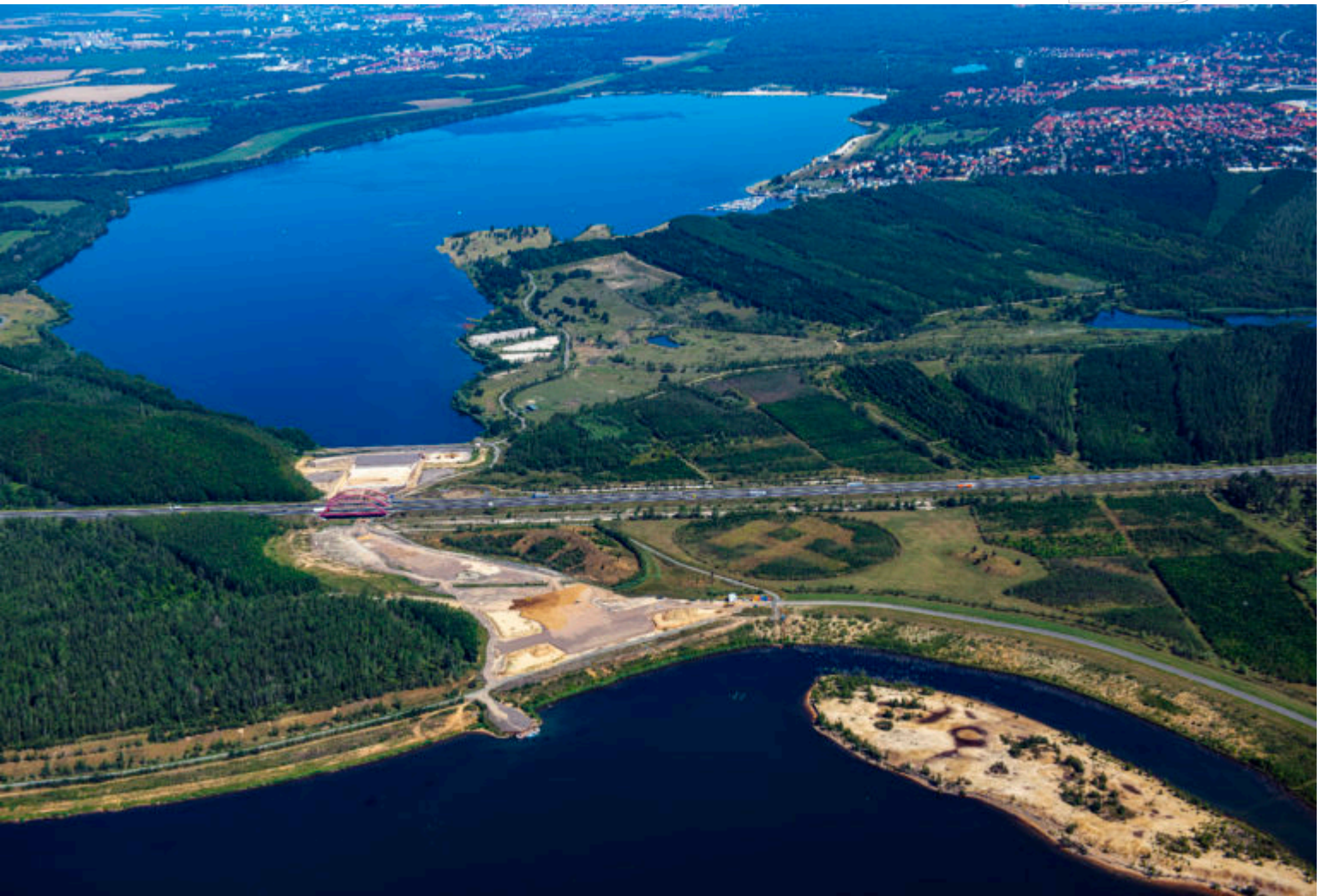
Ruhende Baustelle Harthkanal – Archivfoto v. P. Radke
