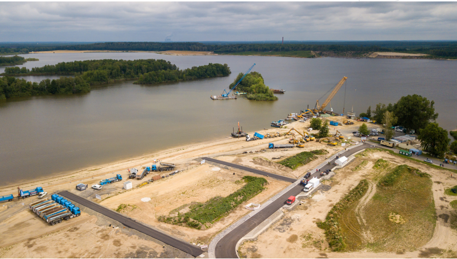
Baustelleninformationstag am Knappensee 2022
