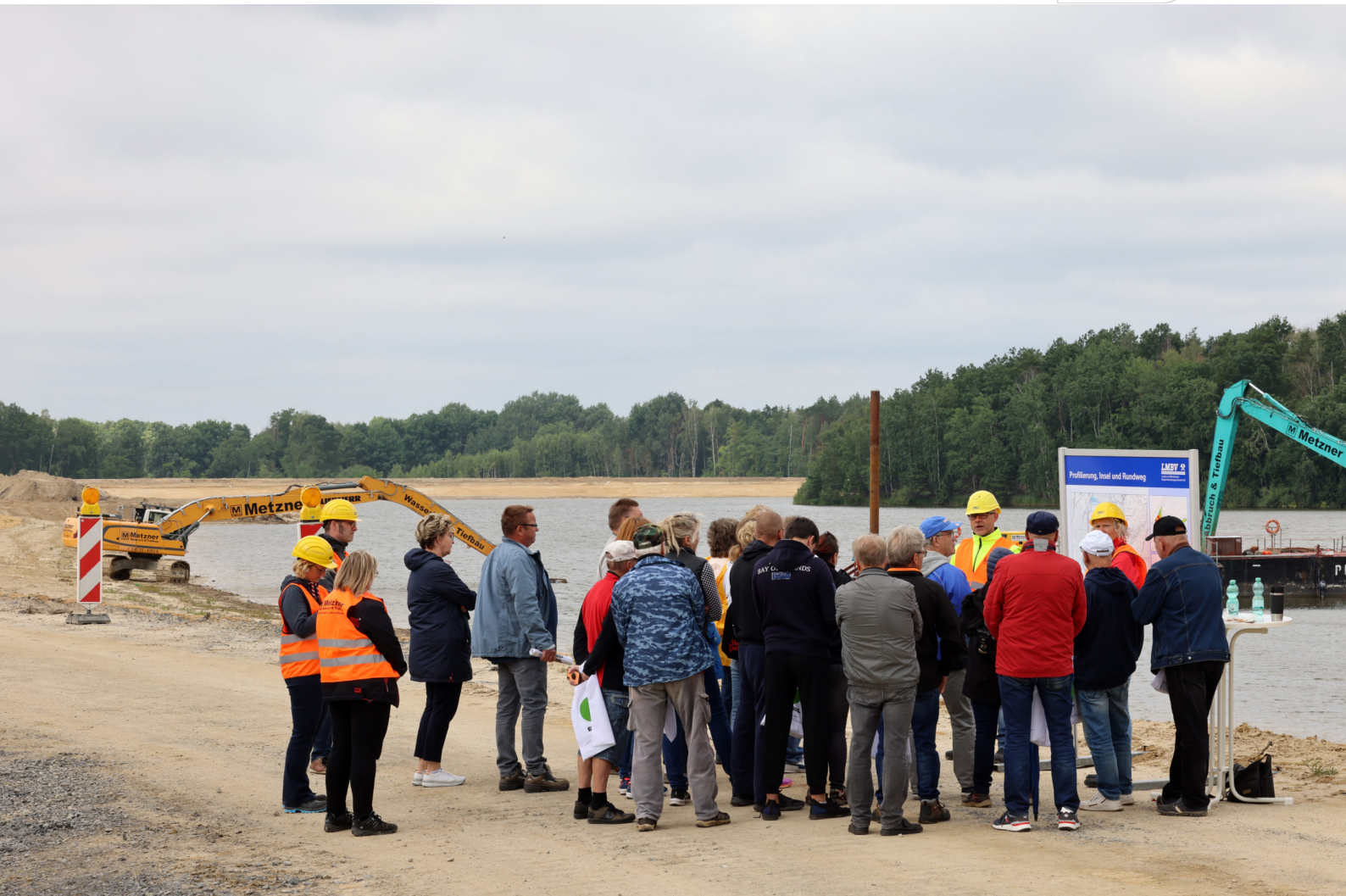
Baustelleninformationstag am Knappensee 2022
