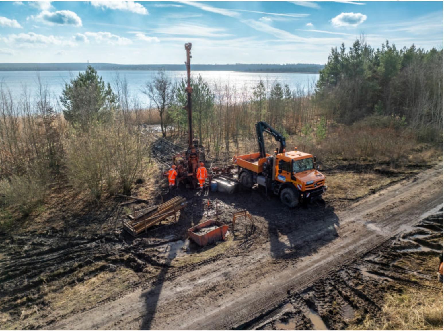
Ufersicherung im Tiefbau 2024: Ein Hohlraum wird gesucht, angebohrt und verfüllt.
