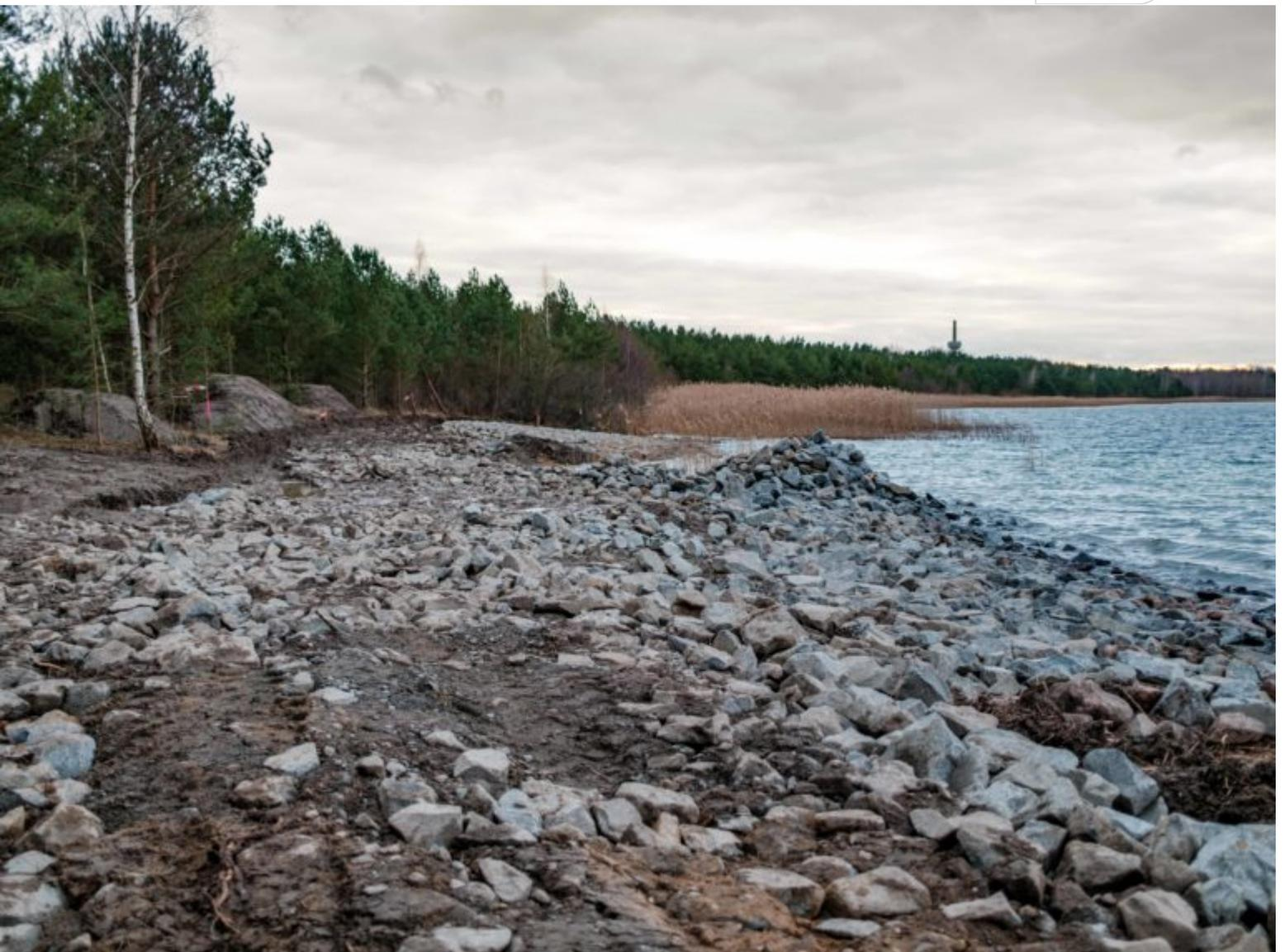
Mit Wasserbausteinen wird das Ufer gegen Wellenschlag gesichert.
