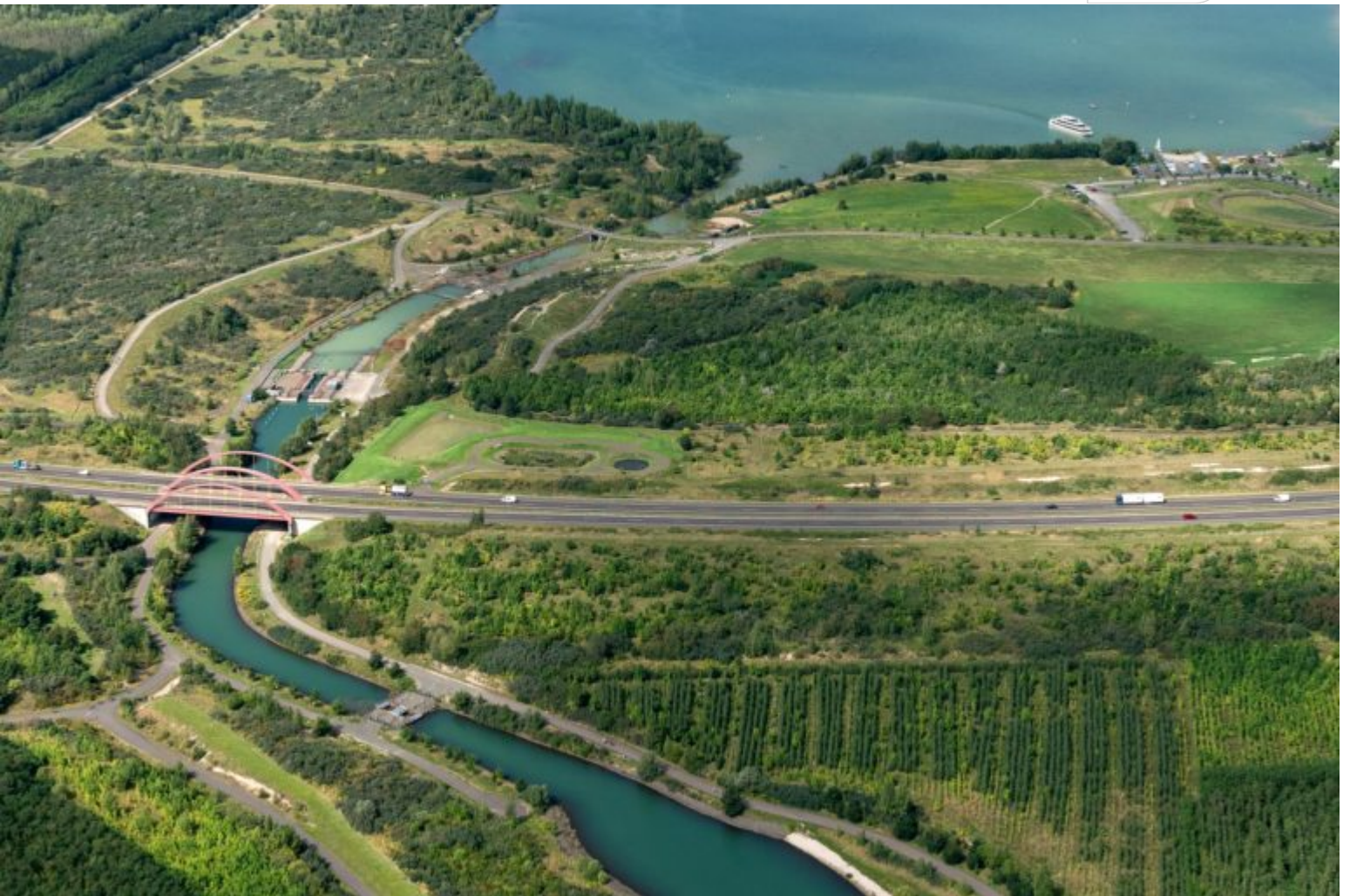
Stormthaler Kanal mit Fußgängerbrücke, unterem Querbauwerk, Schleuse, Autobahnbrücke und oberem Querbauwerk, 2023 (Foto: Ch. Kortüm)
