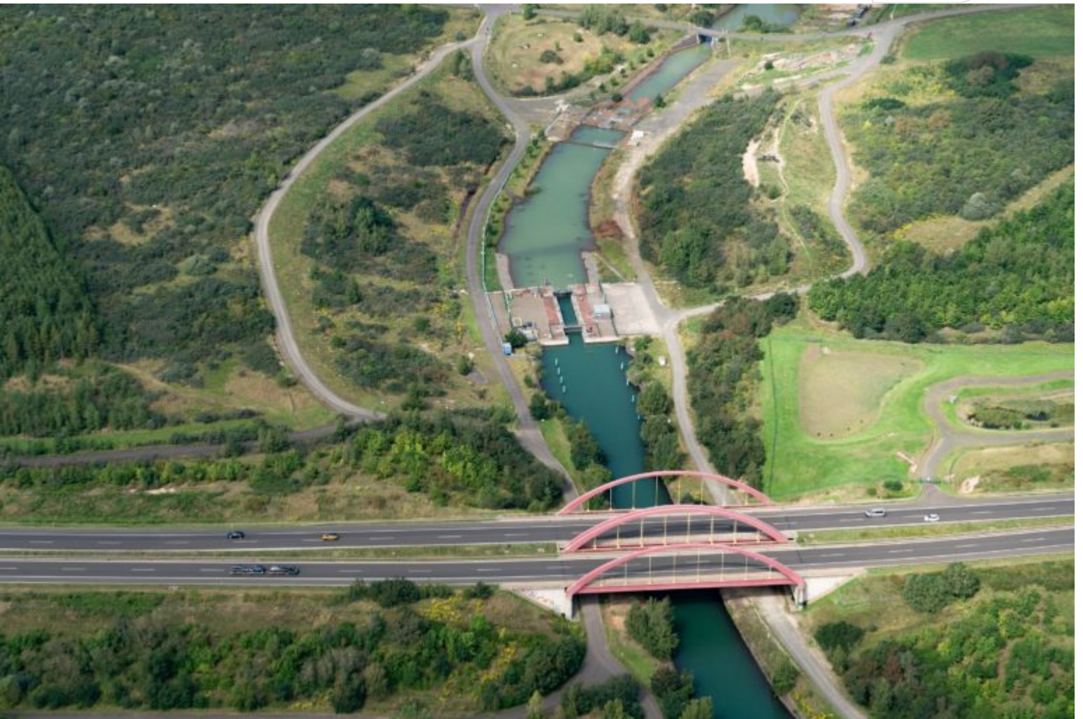
Die Schleuse im Störmthaler Kanal mit dem Querbauwerk im Unterhafen, Richtung Markkleeberger See, 2023 (Foto: Ch. Kortüm)
