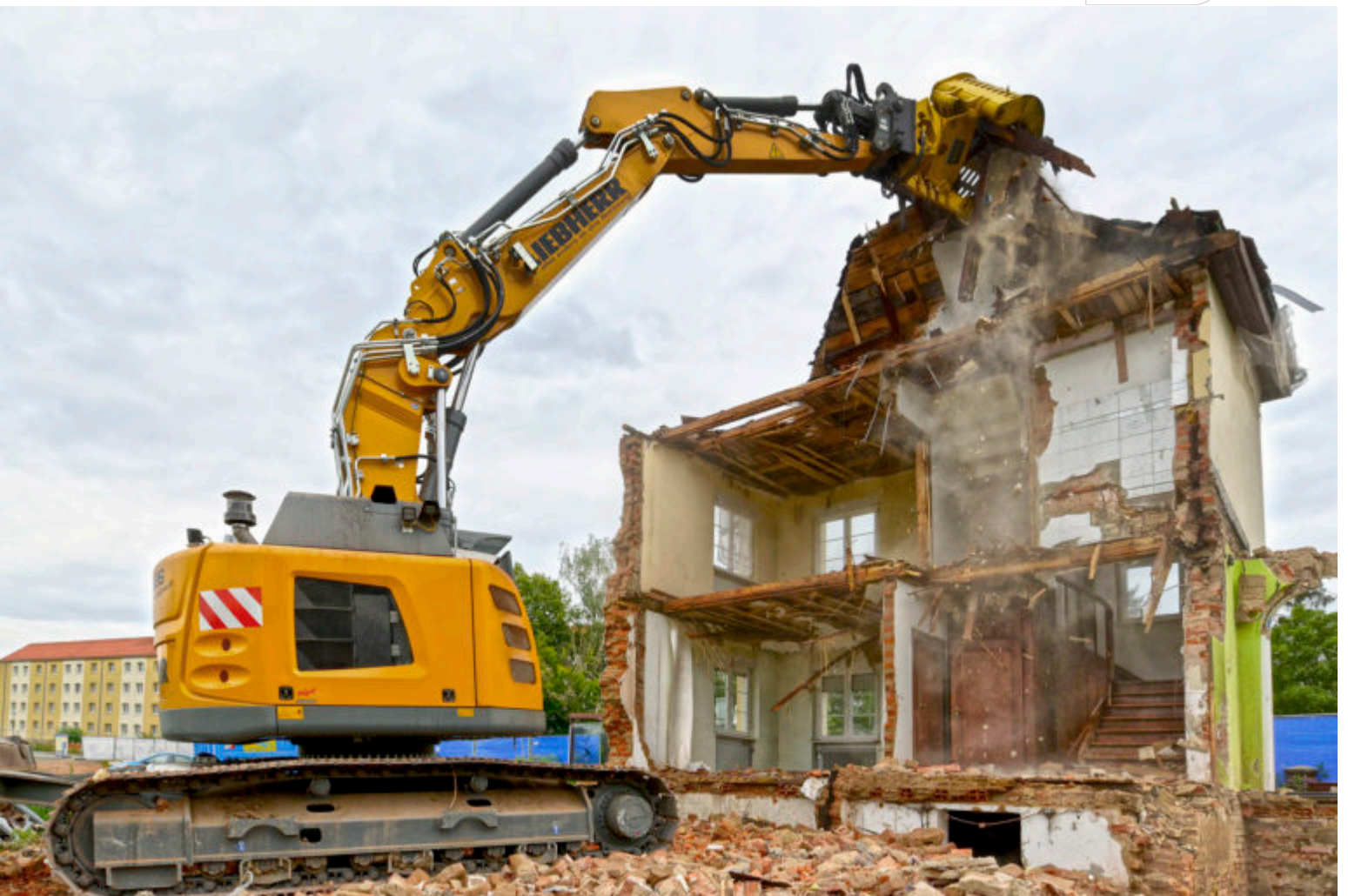
Rückbau von kontaminierten Gebäuden
