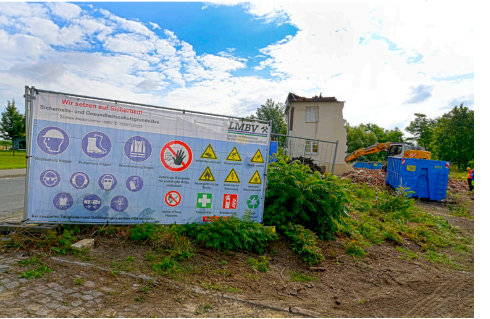
Thüringer Altlastenprojekt in Projekträgerschaft der LMBV
