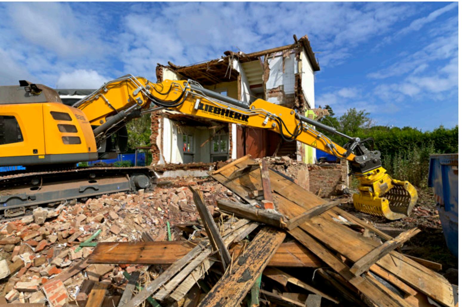
Rückbau in Rositz
