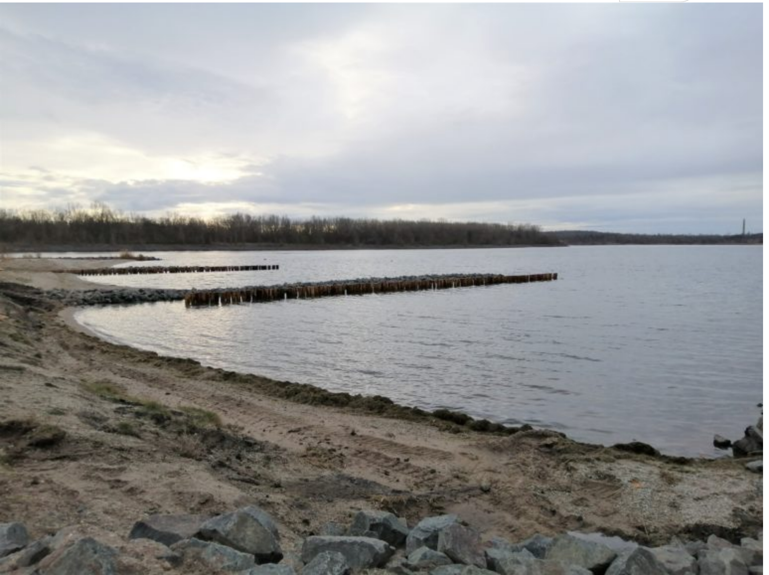
Aller 35 Meter entsteht die nächste Buhne
