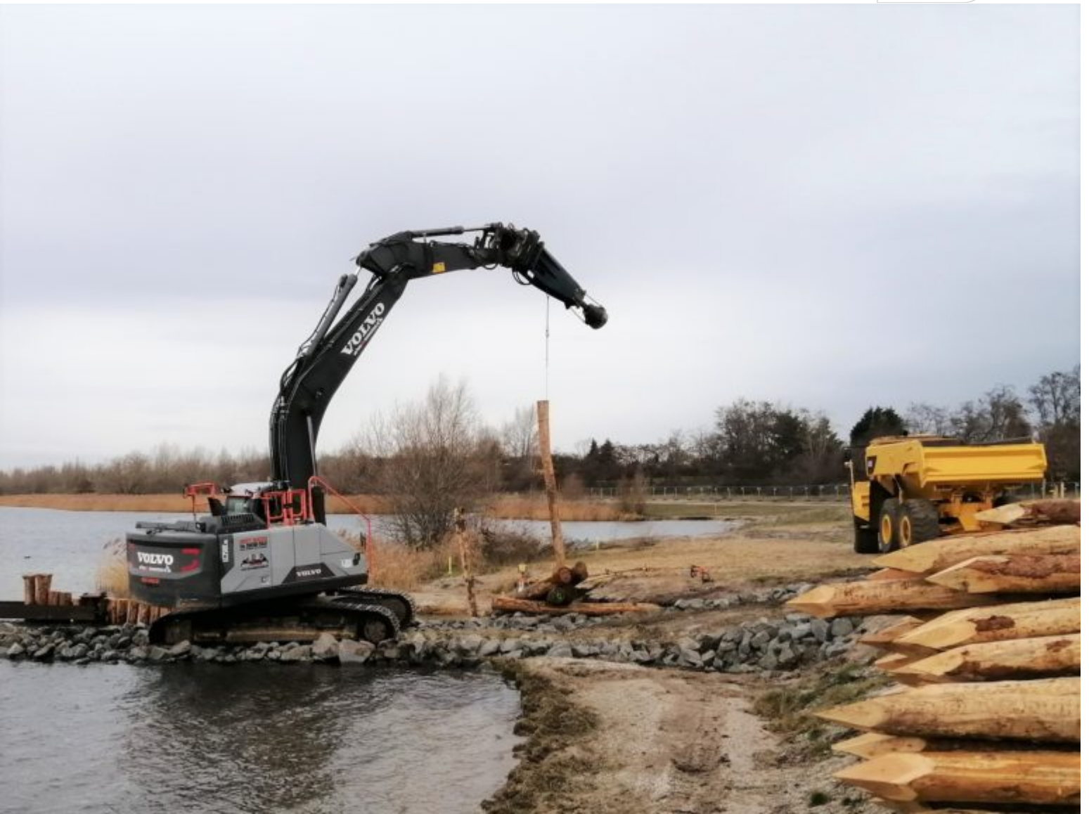
Aufnahmen per Kettenbagger
