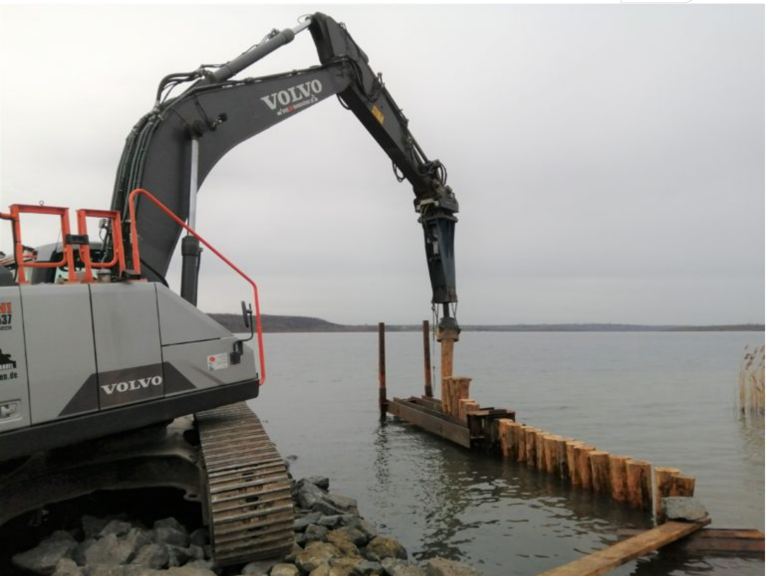
Einbau per Vorsatzrammgerät
