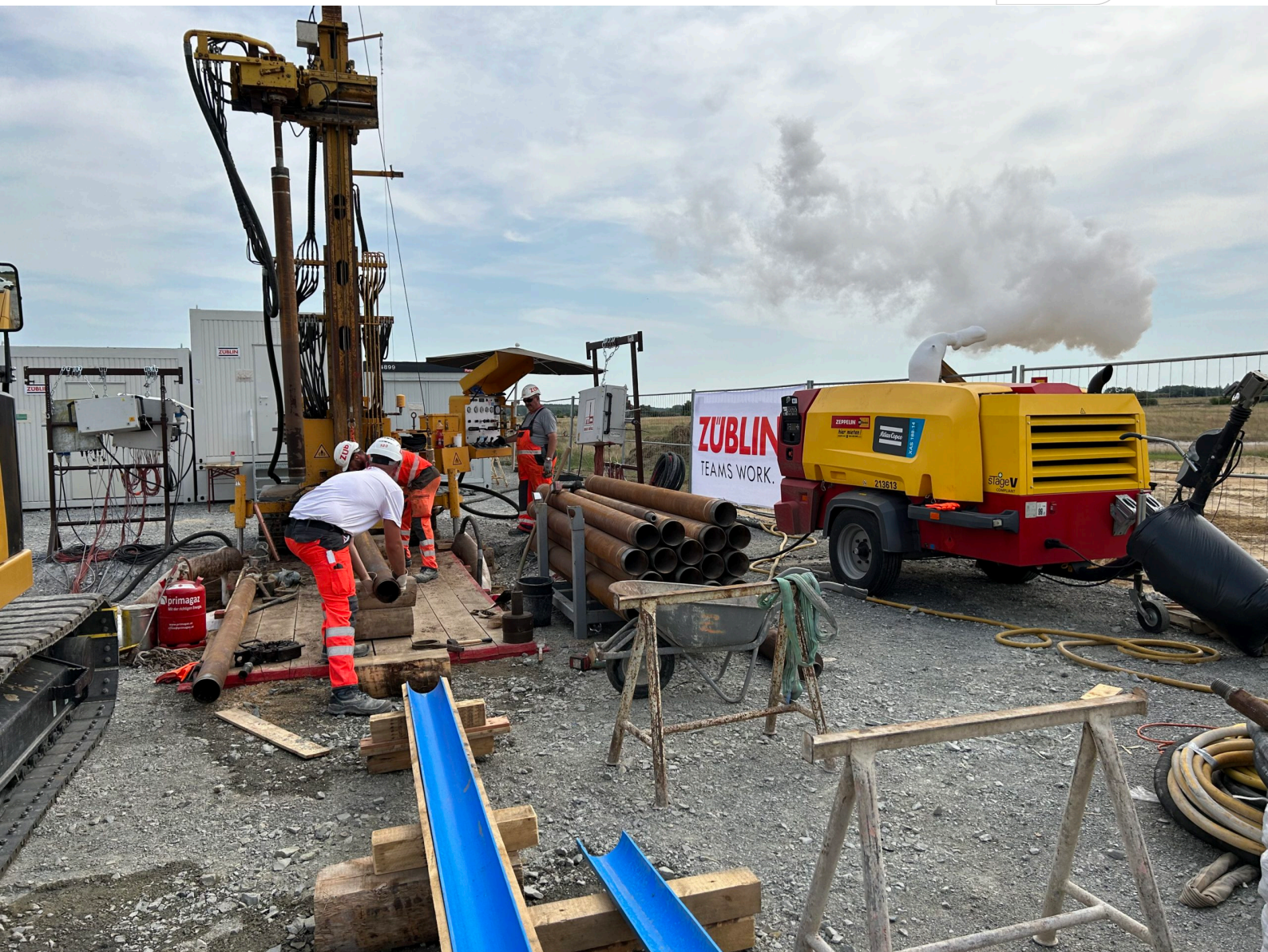
Bohrteam der Fa. Züblin an der Bohrstelle 1 im Tagebau Seese-Ost im Einsatz.
