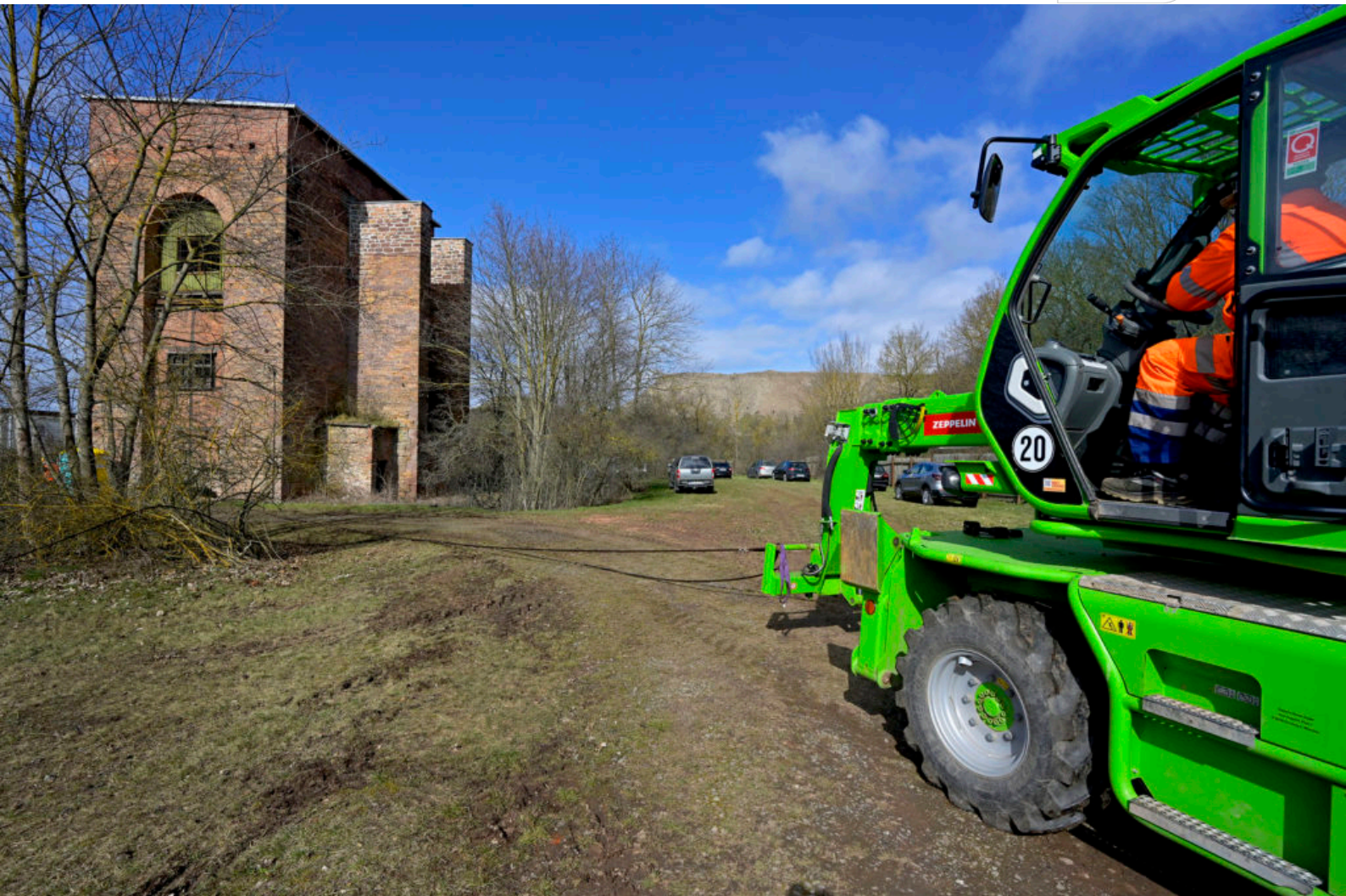
Erneuerung der Führungsseile auf der Schachtanlage Freieslebenschacht 2 der LMBV, Sparte Kali-Spat-Erz, KSE, in Großbörrner im ehemaligen Mansfelder Kupferschiefer-Revier. Foto am 22. März 2021.
