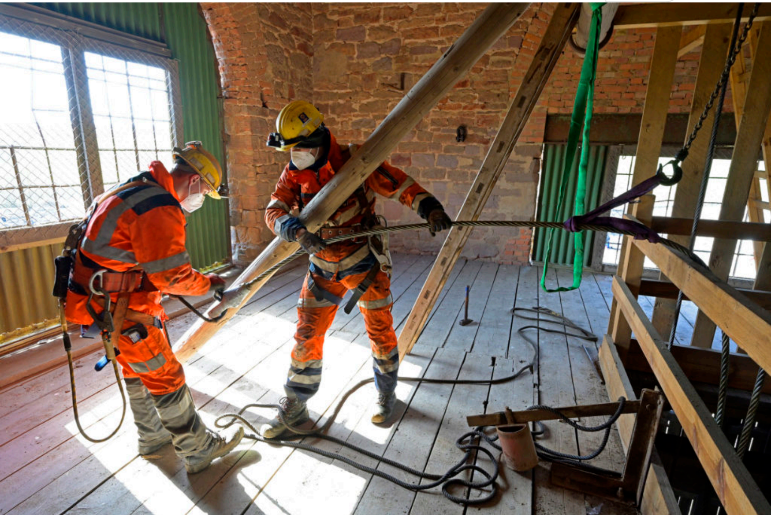
Erneuerung der Führungsseile auf der Schachtanlage Freieslebenschacht 2 der LMBV, Sparte Kali-Spat-Erz, KSE, in Großörner im ehemaligen Mansfelder Kupferschiefer-Revier. Foto am 22. März 2021.
