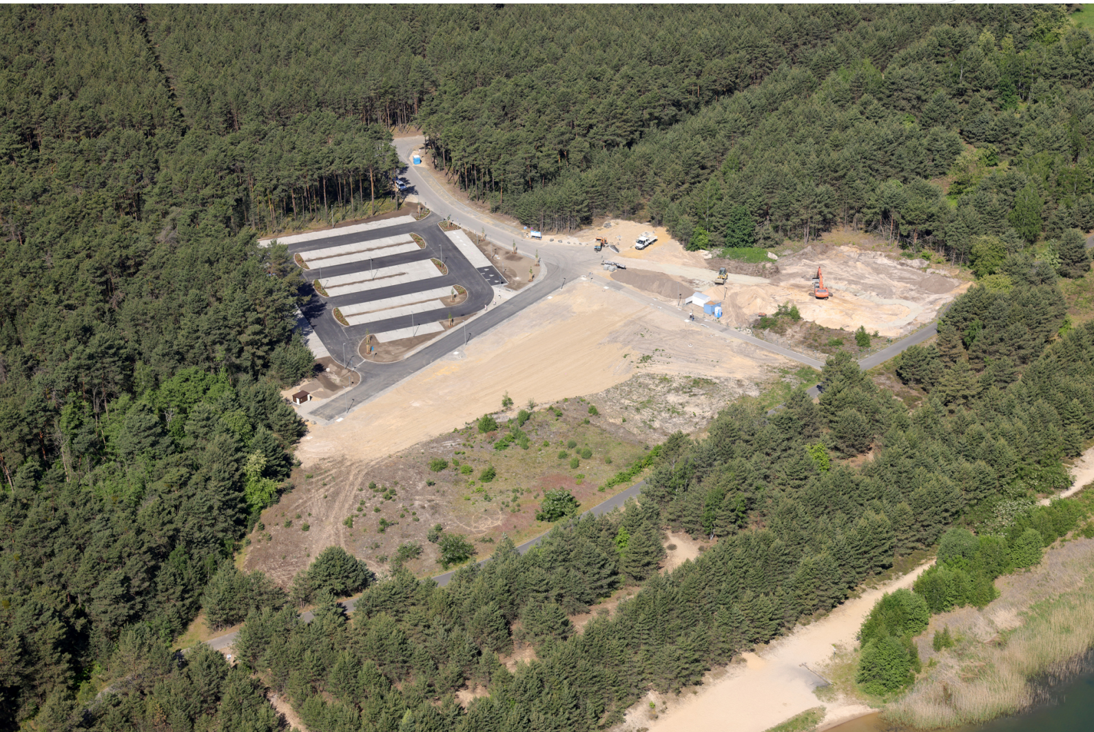
Blick auf den entstehenden Spielplatz am Scheibe-See
