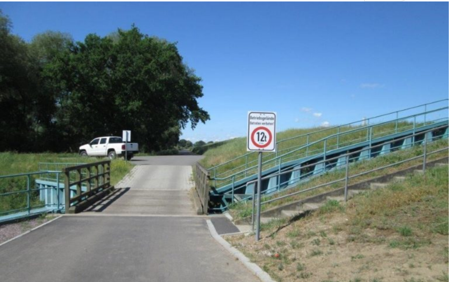
Die Flutungsanlage mit Wirtschaftsweg und Brücke vor ihrer Sperrung (Foto: LMBV, 2020)
