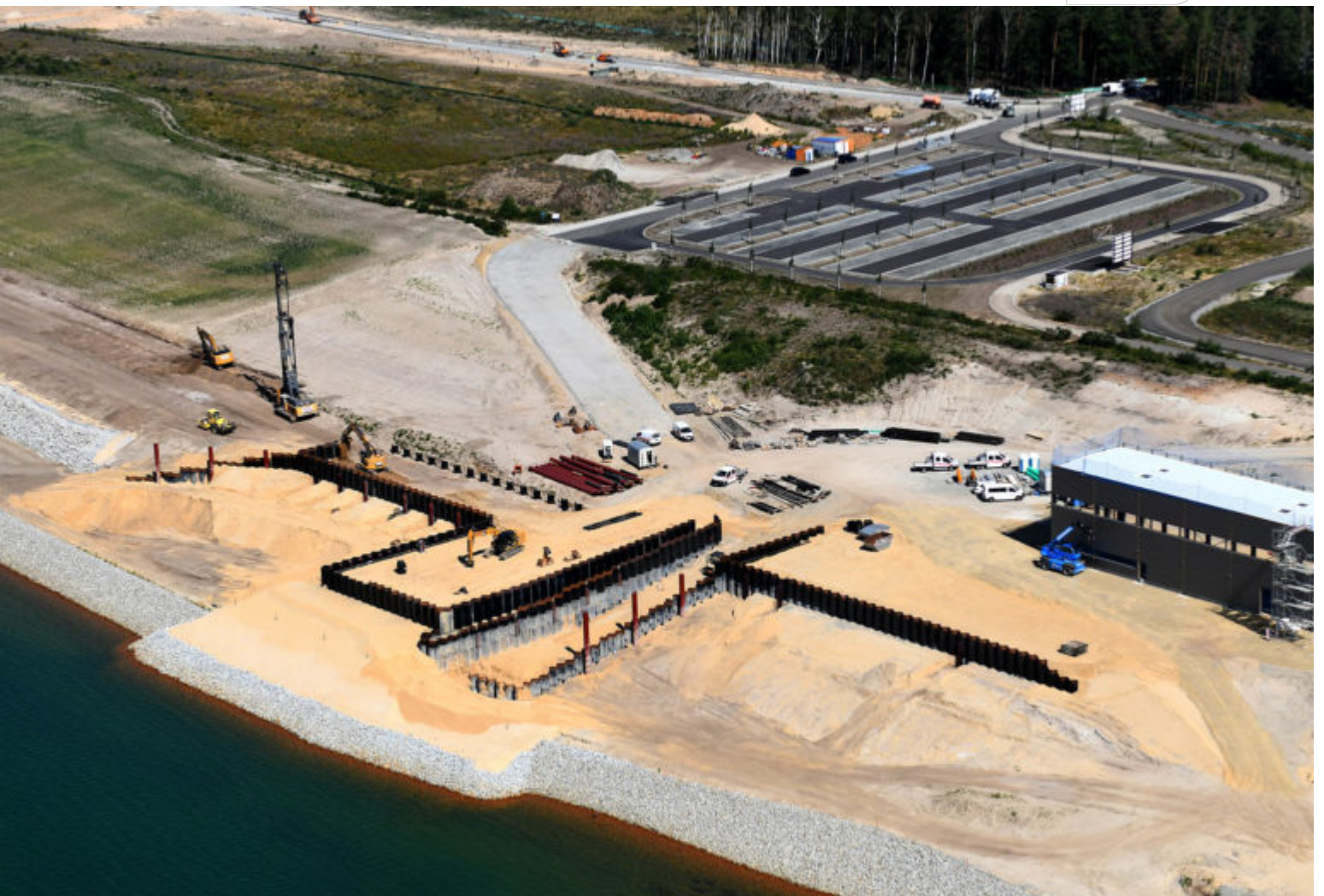
Sanierungsstützpunkt im Bau
