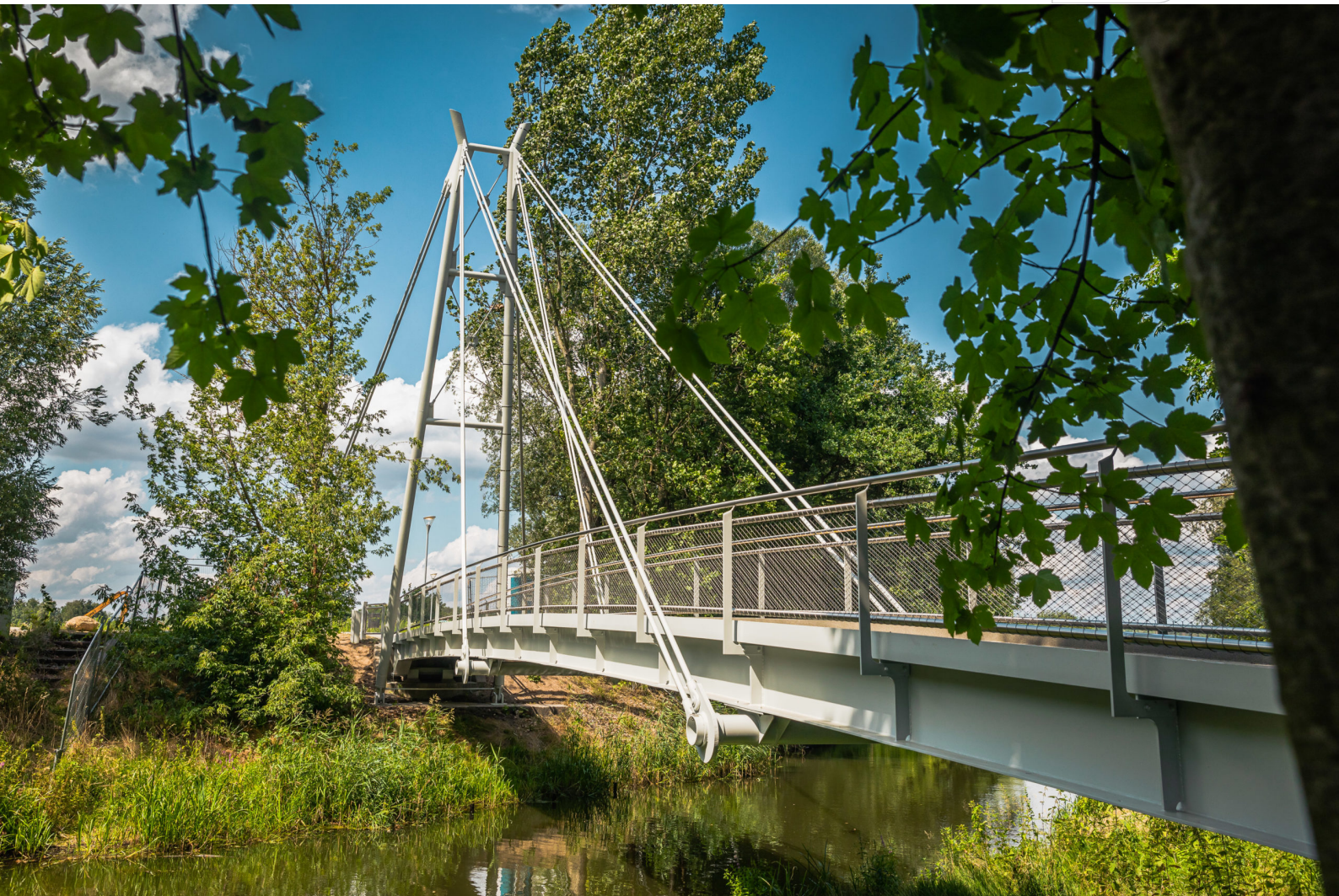
Ertüchtigte Fußgängerbrücke am Knappensee-Einlauf
