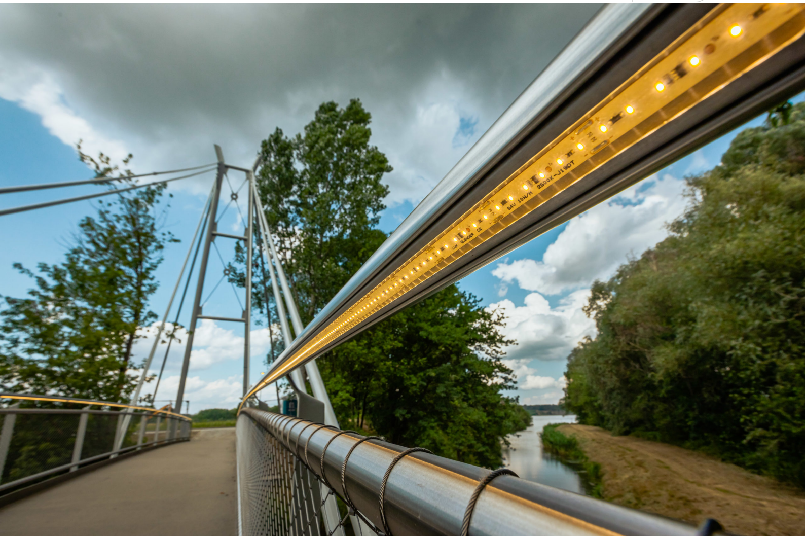
Beleuchtetes Handlaufgeländer
