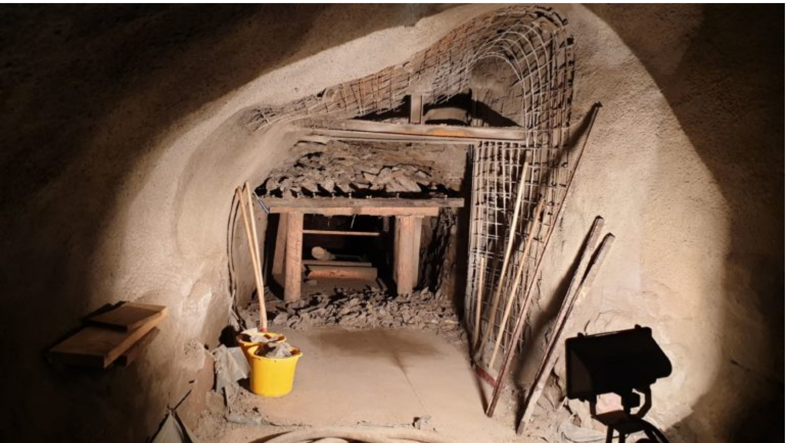
Hergestellter Ausbau in Blickrichtung Schlüsselstollen
