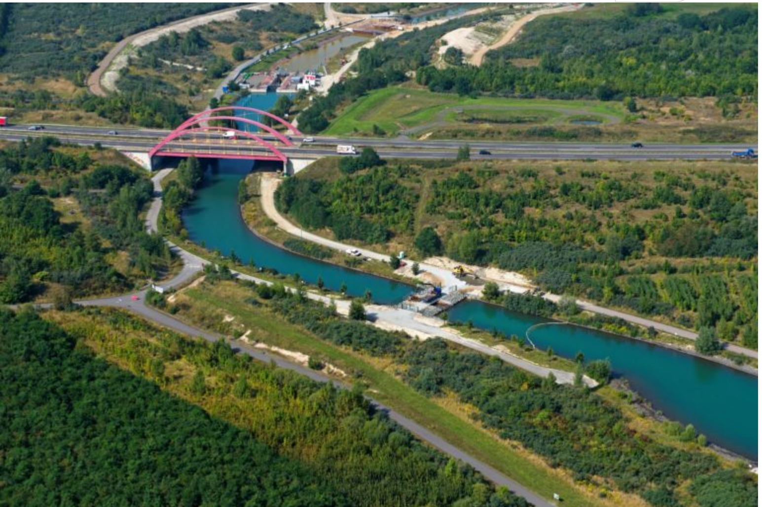
Störnthaler Kanal mit Sicherungsbauwerken aus südöstlicher Richtung im September 2021 (Foto: LMBV / Christian Bedeschinski)
