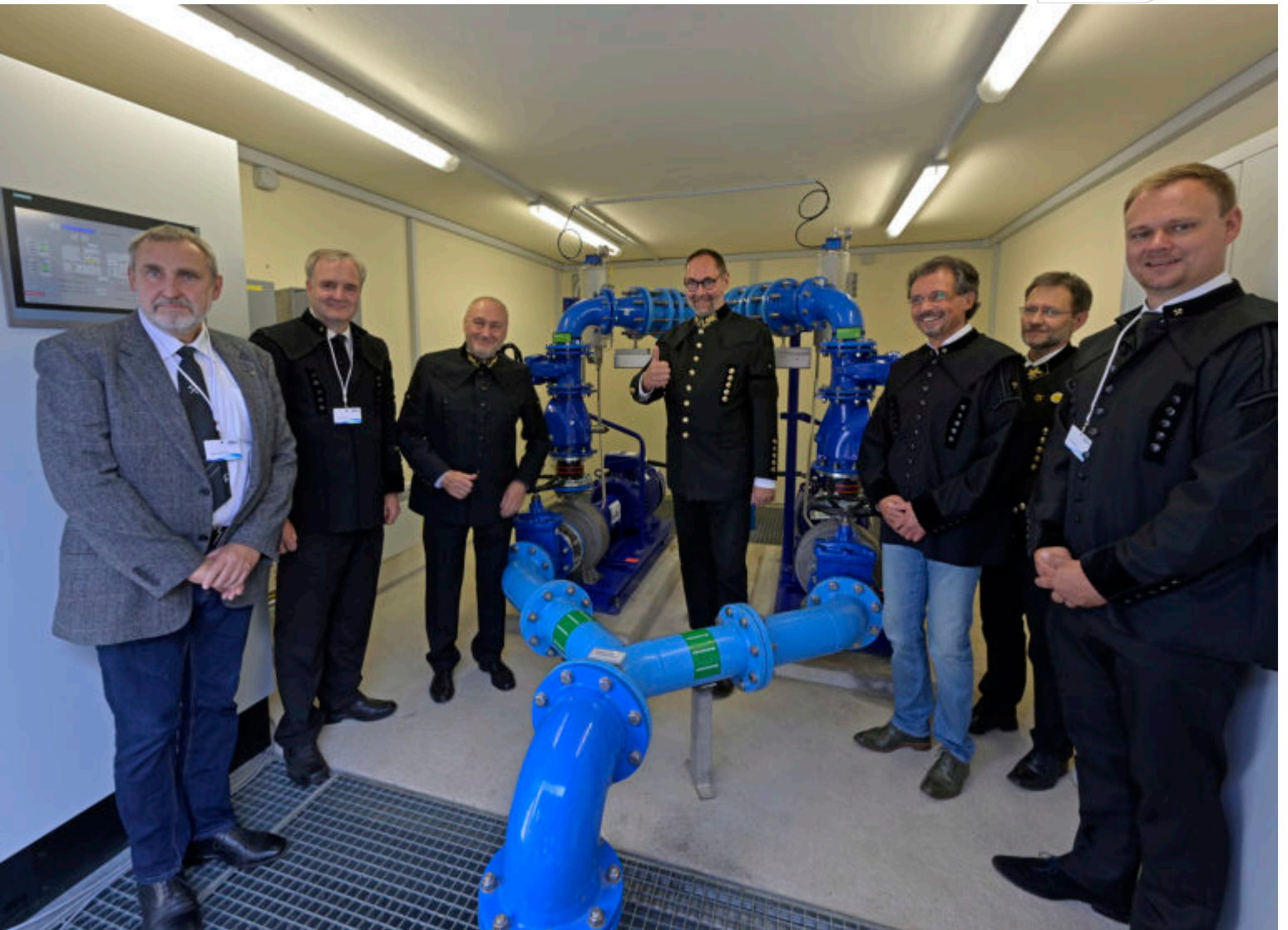
Besichtigung der Pumpanlage
