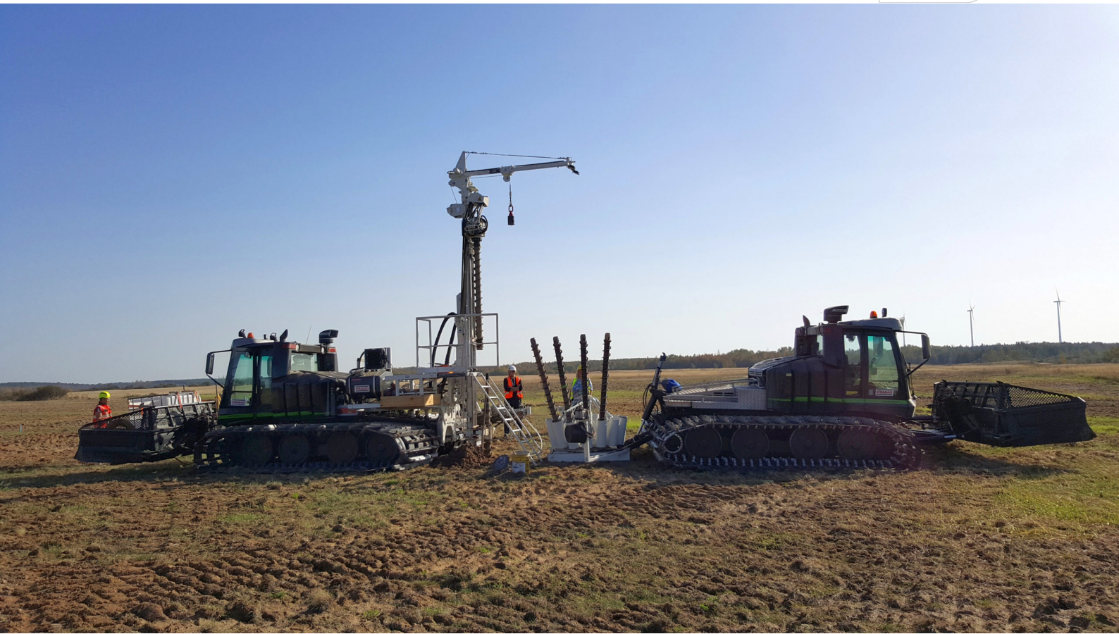
Schonende Sprengverdichtung / Foto: Dieter Kutzschbach
