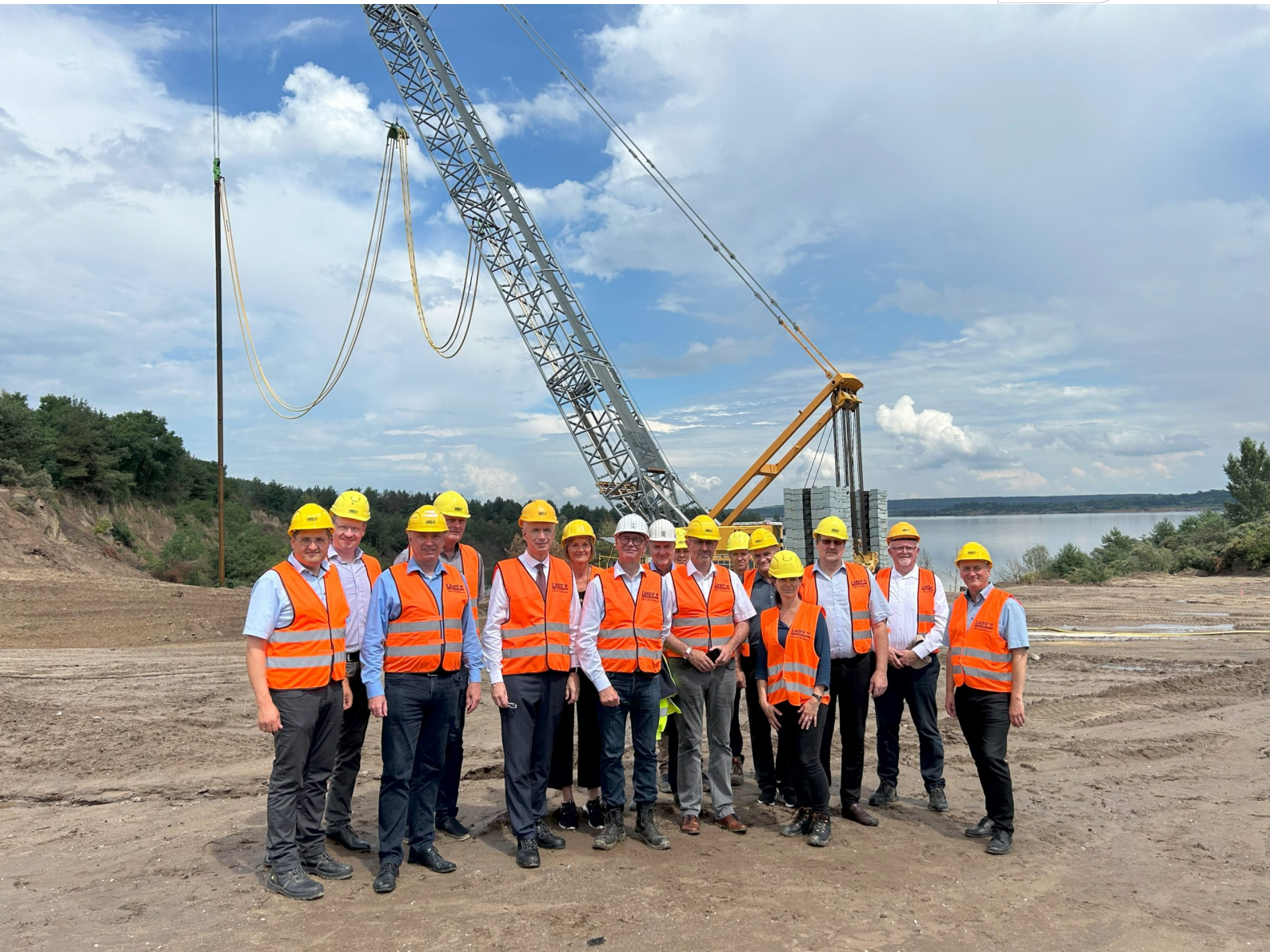
Am Restloch Greifenhain, wo derzeit die Rütteldruckverdichtung stattfindet.
