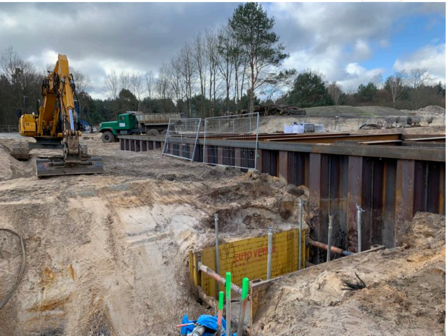
MWBA Ruhlmühle der LMBV im Aufbau
