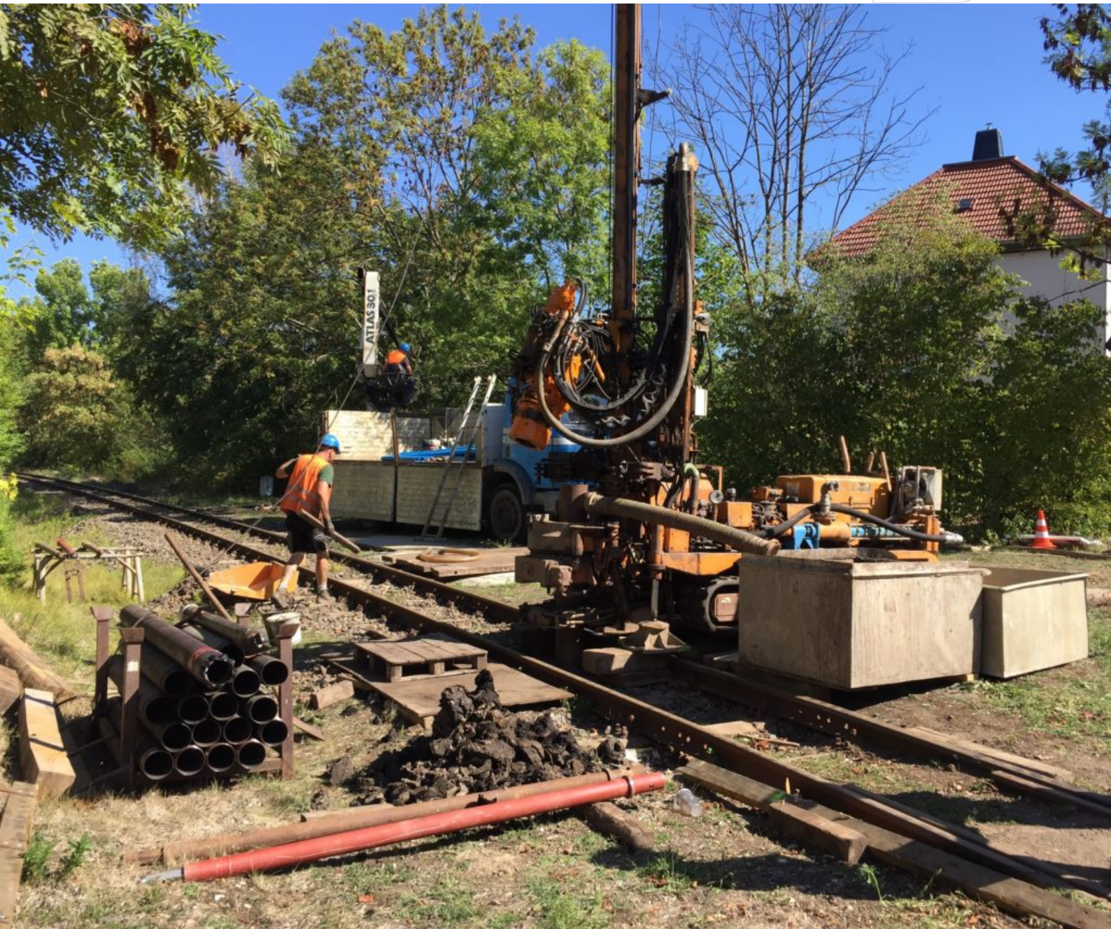
Erkundungsbohrungen Kohletraditionsbahn Meuselwitz (2018/2019)
