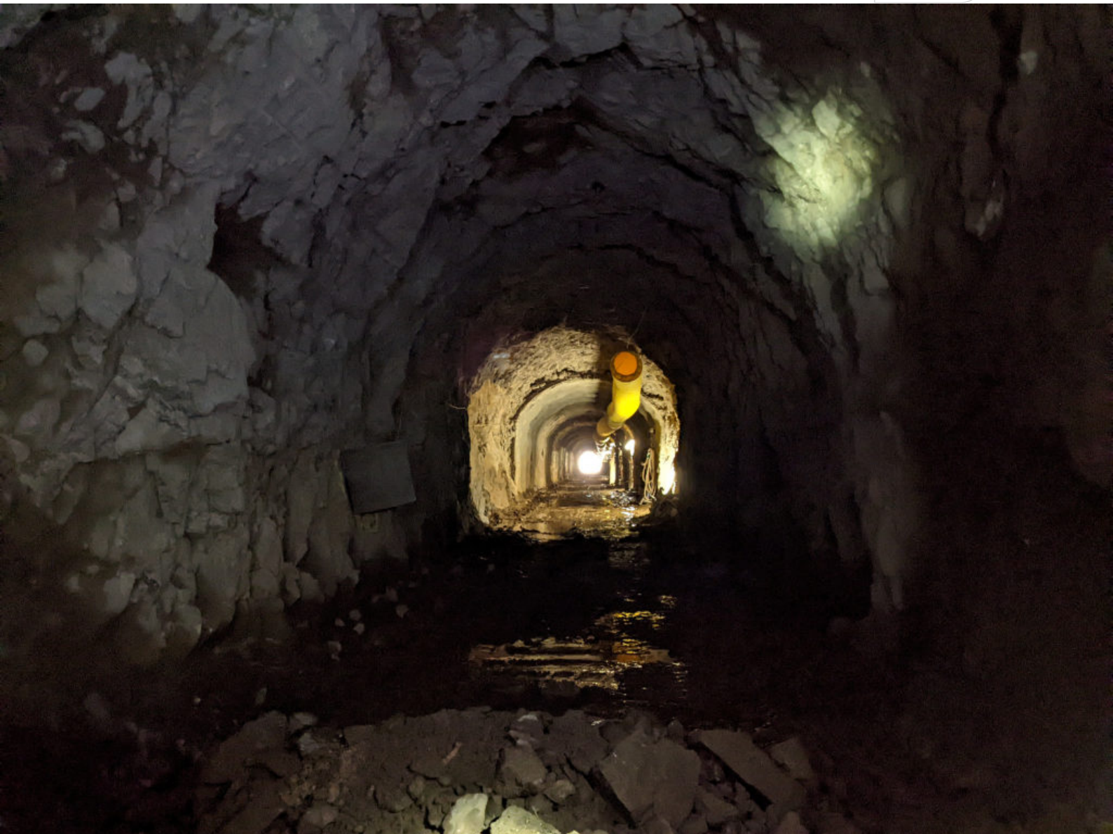
Blick aus dem zukünftigen neuen Steinbachstollen
