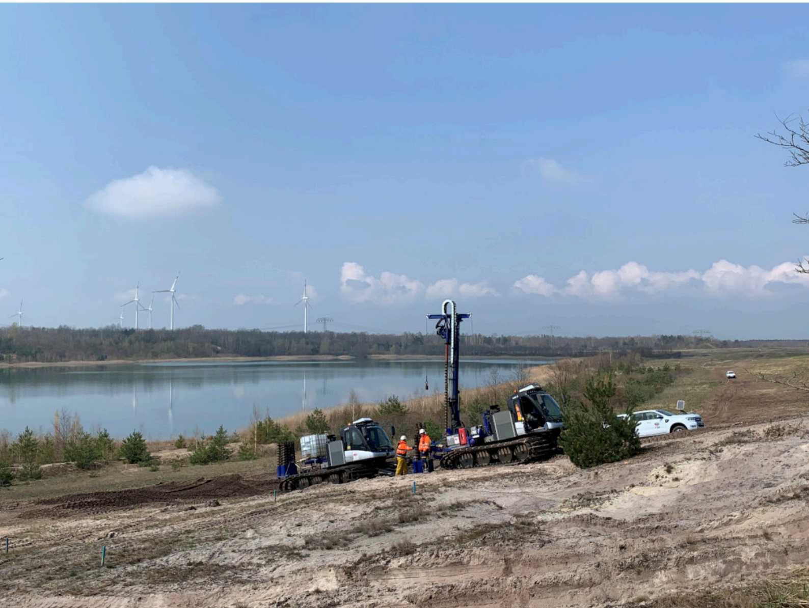
TDE-Bohrtrupp auf der Gefährdungsfläche Süd am Restloch 23 (Bischdorfer See) im Einsatz
