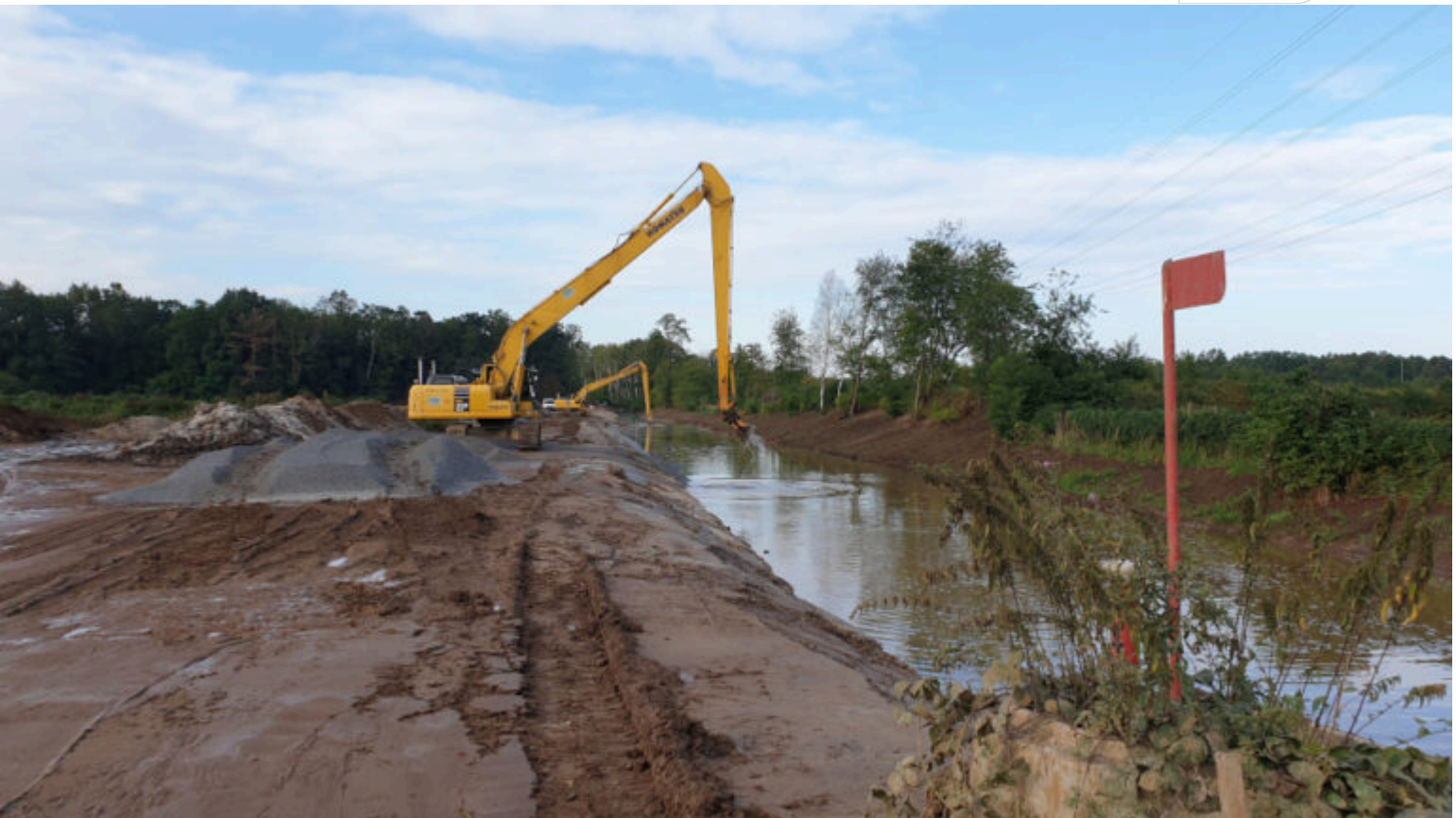
Einseitiger Ausbau der Kleinen Spree
