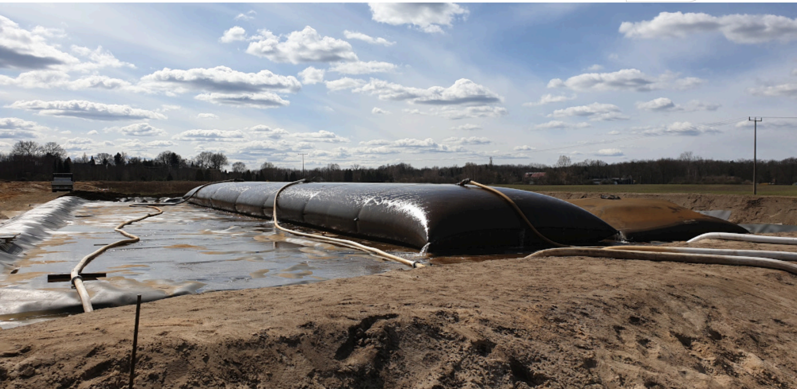
Aufnahmebehälter aus Geotextil für abgesaugten Schlamm aus Kleiner Spree Ausbau-Fotos aus 2020
