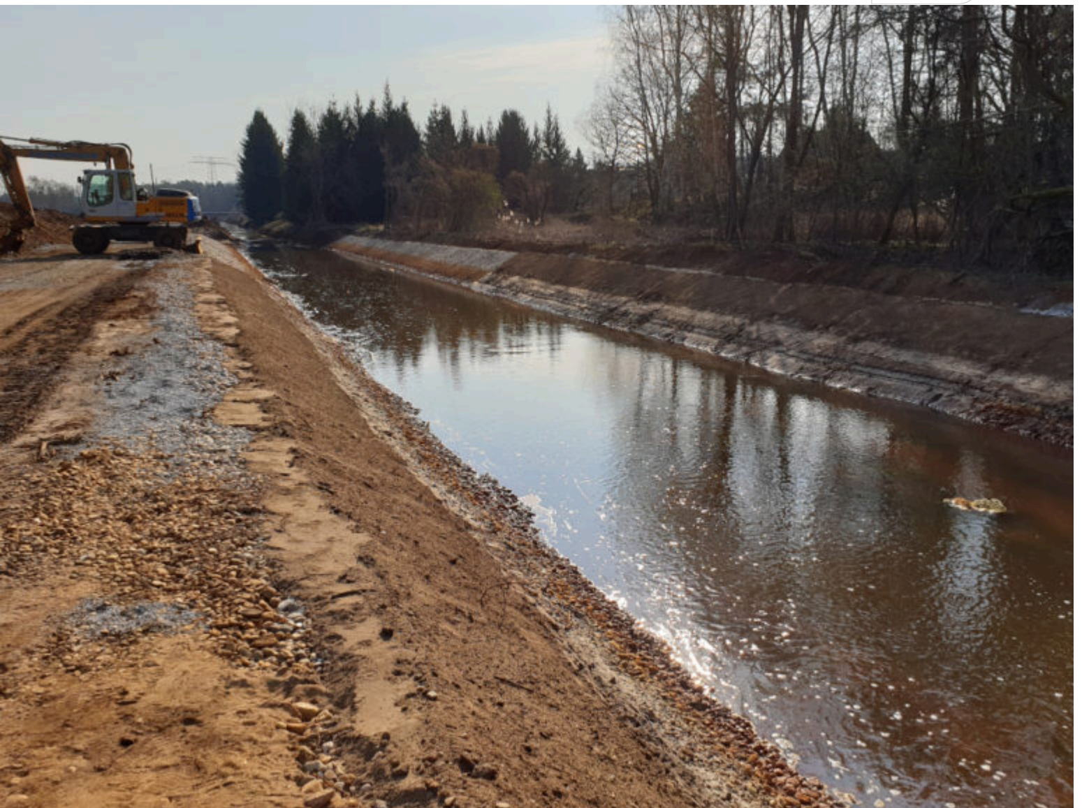
Uferausbau an der Kleinen Spree
