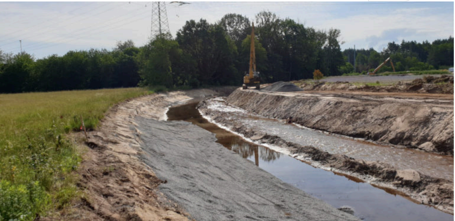
Arbeiten in der laufenden Welle der Kleinen Spree
