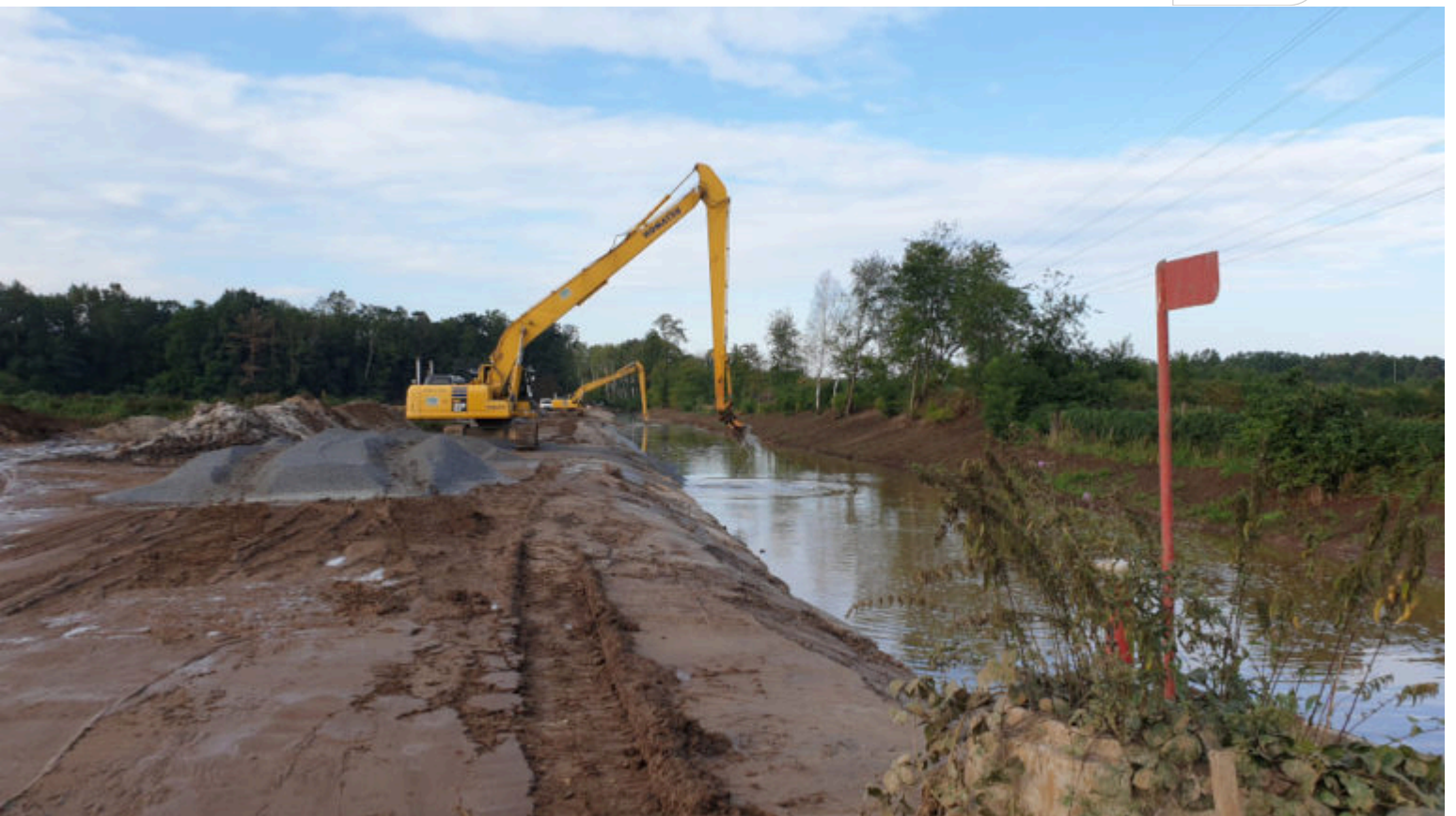
Einseitiger Ausbau der Kleinen Spree
