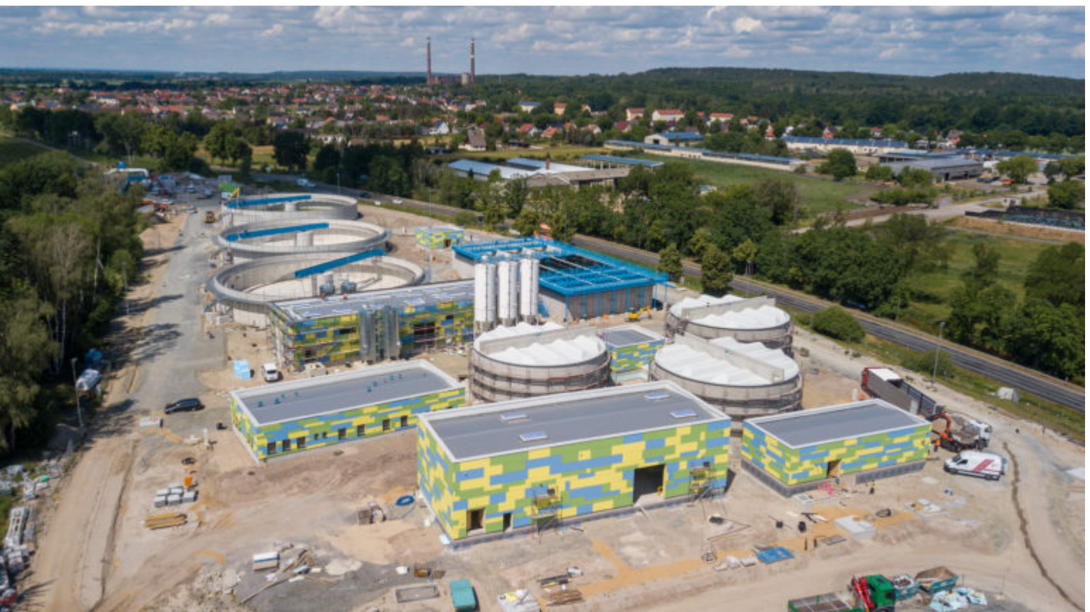
Die im Bau befindliche LMBV-Wasserbehandlungsanlage Plessa (Juni 2022)
