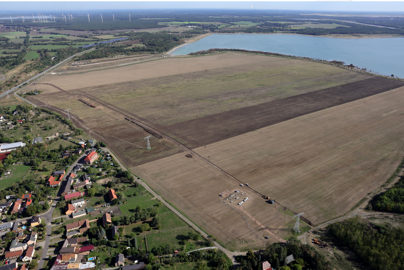
Errichtung der Nordzufahrt zu Brückenfeldkippe Sedlitz
