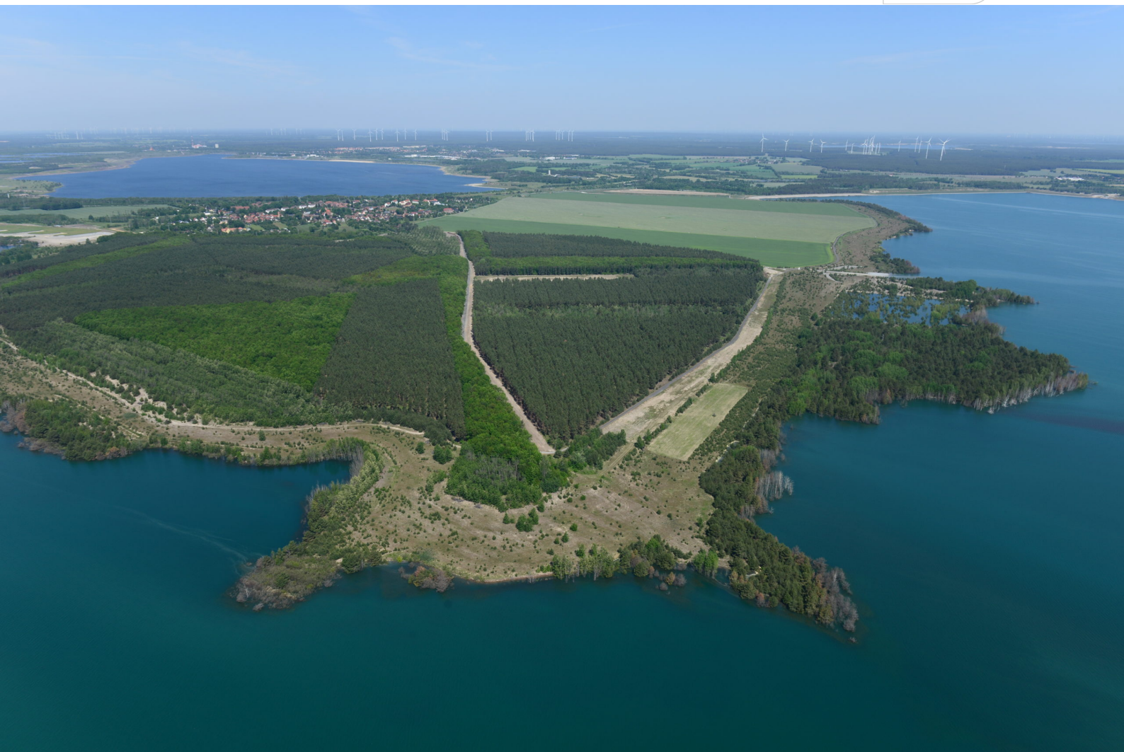
Brückenfeldkippe von oben
