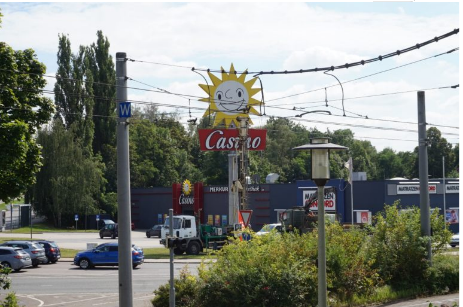
Mitten im bebauten Gebiet: Bohrungen für Messstellen
