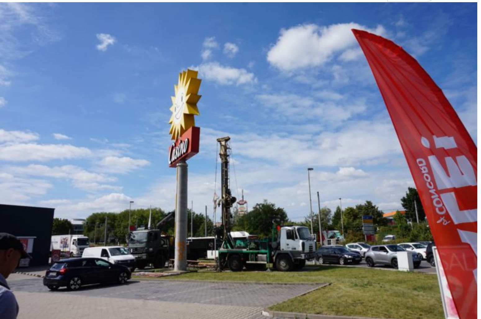
Bohrerkundungsprogramm im Abstrom der Grundwassereinigungsanlage Schedewitz
