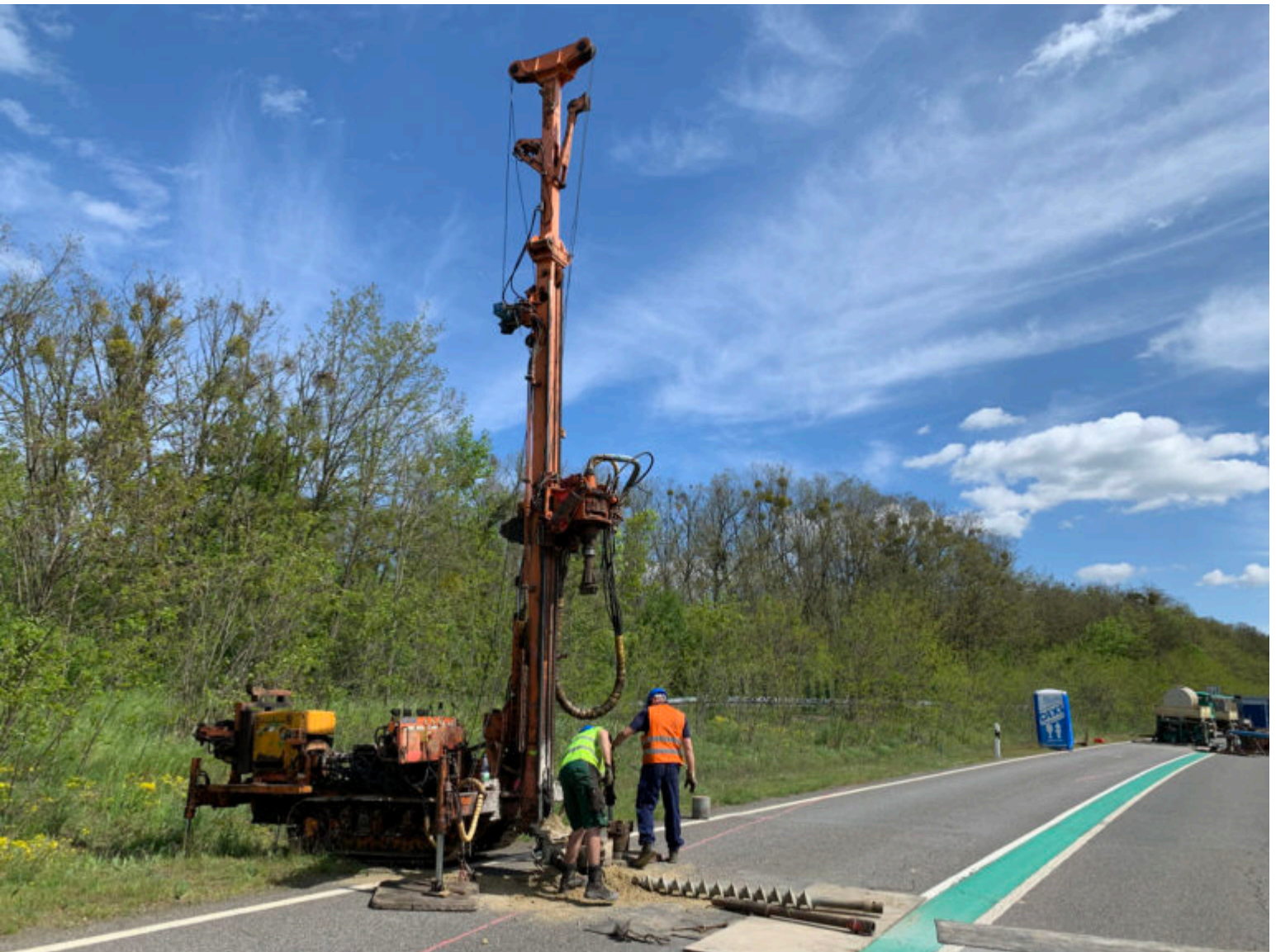
Bohren mit Gerät der BLZ Gommern
