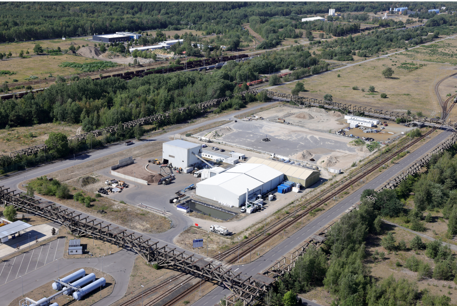
Blick auf die Vakuumthermische Reinigungsanlage (VTRA)
