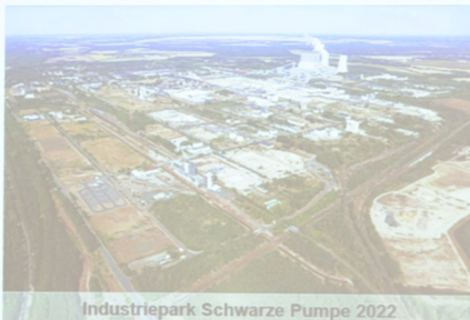
Industriepark Schwarze Pumpe 2022
