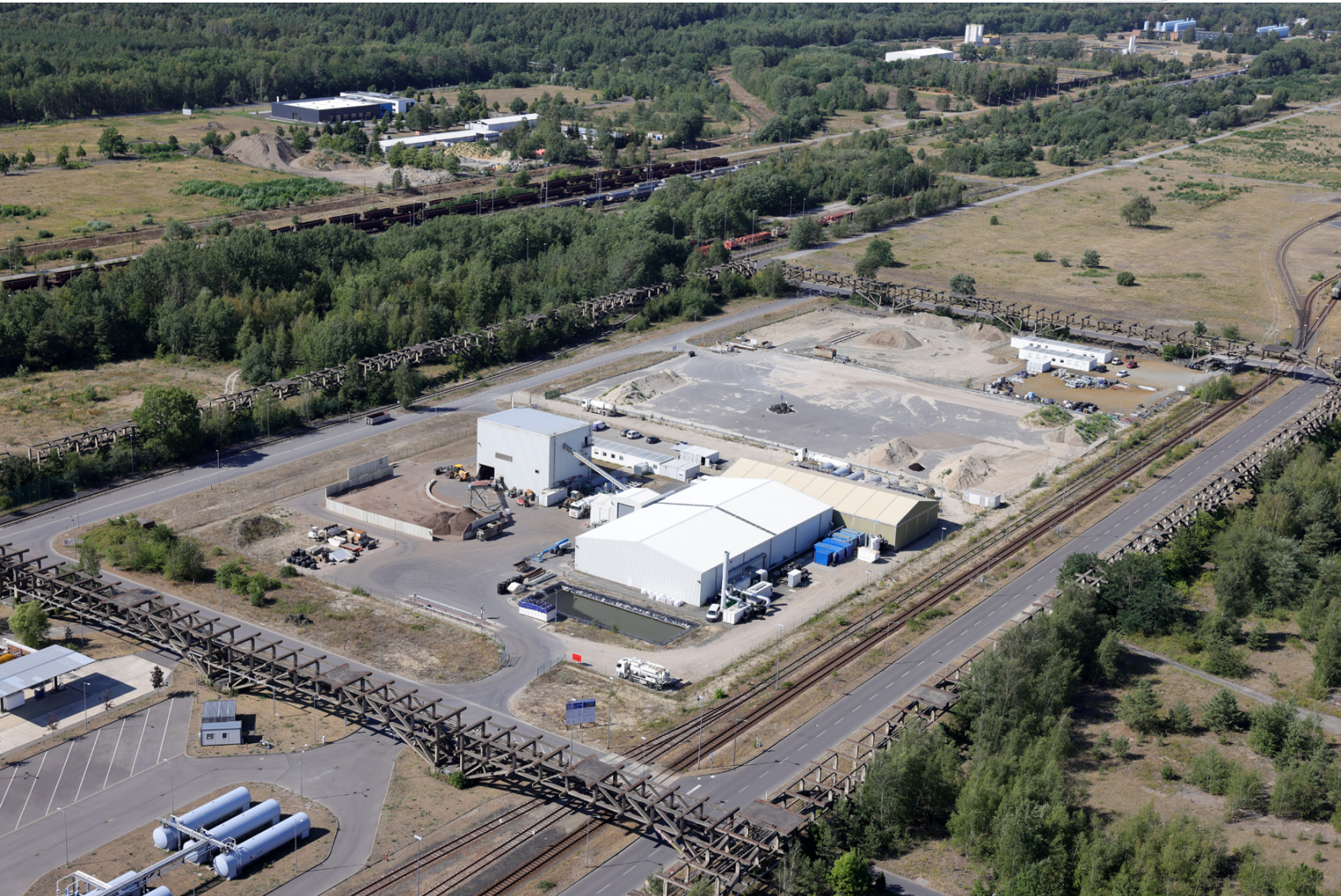
Blick auf die Vakuumthermische Reinigungsanlage (VTRA)
