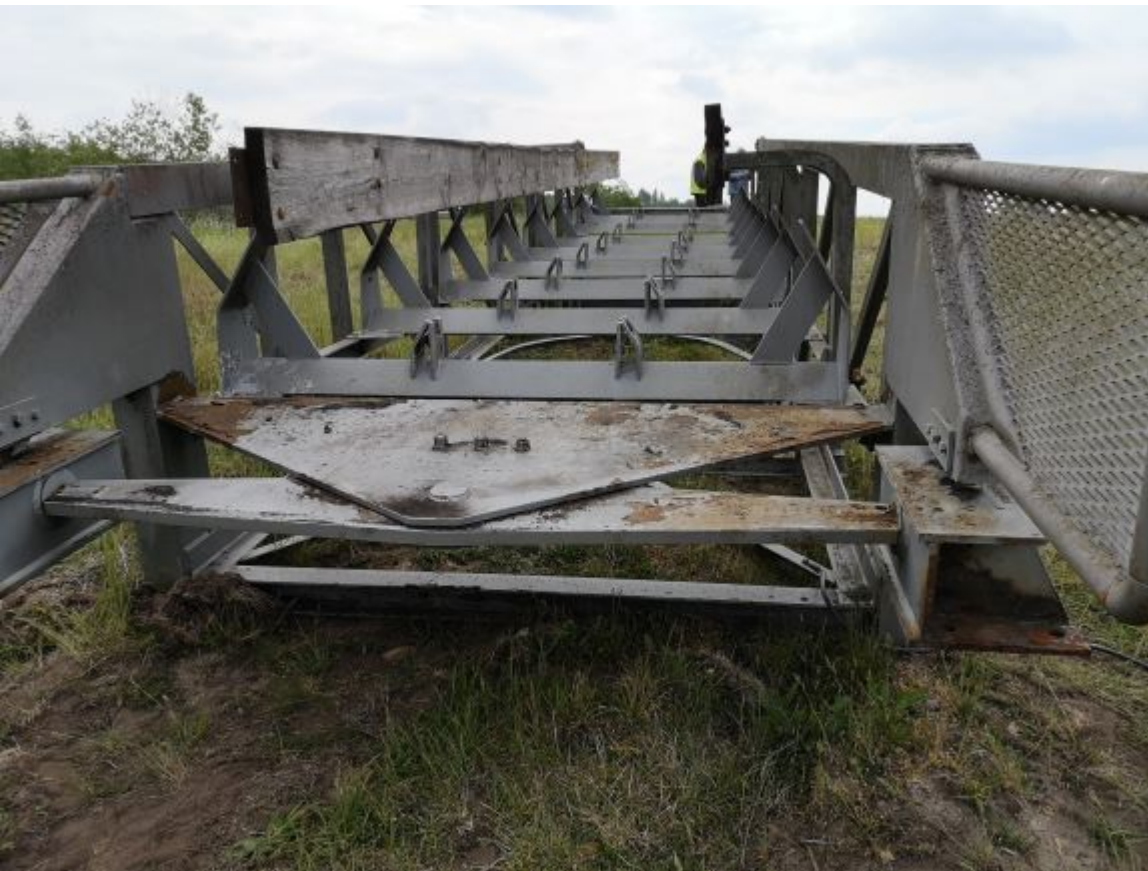
Auflaufbrücke steht am Lappwaldsee (Foto: LMBV)
