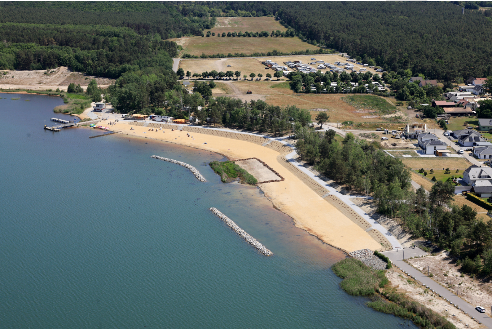
Neu gestaltetes Ufer am Geierswalder See 2023 – mit Wellenbrechern und Anlegesteg
