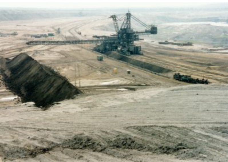
Absetzer im ehem. Tagebau Witznitz
