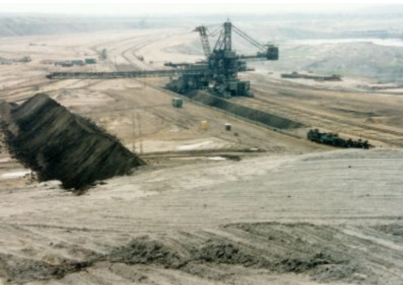
Absetzer im ehem. Tagebau Witznitz
