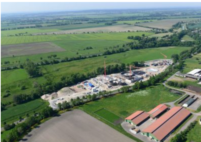
Bau der Wasserbehandlungsanlage bei Plessa
