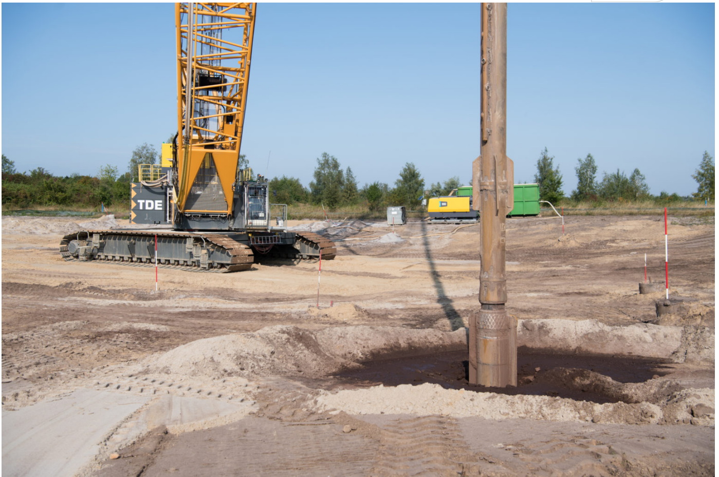
RDV-Bagger im Einsatz
