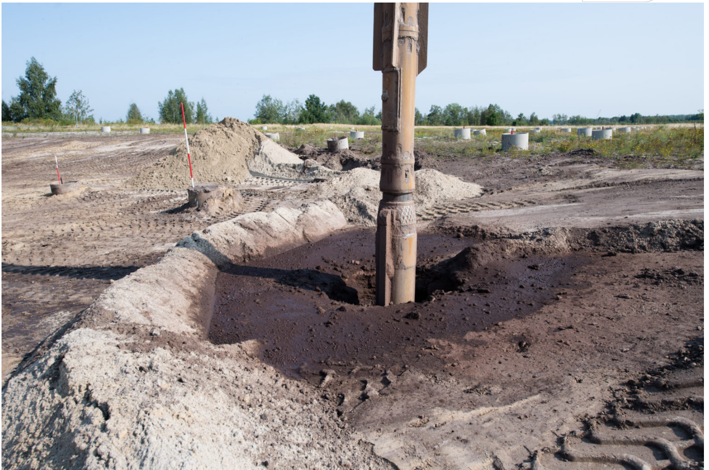
Rüttellanze zur Verdichtung
