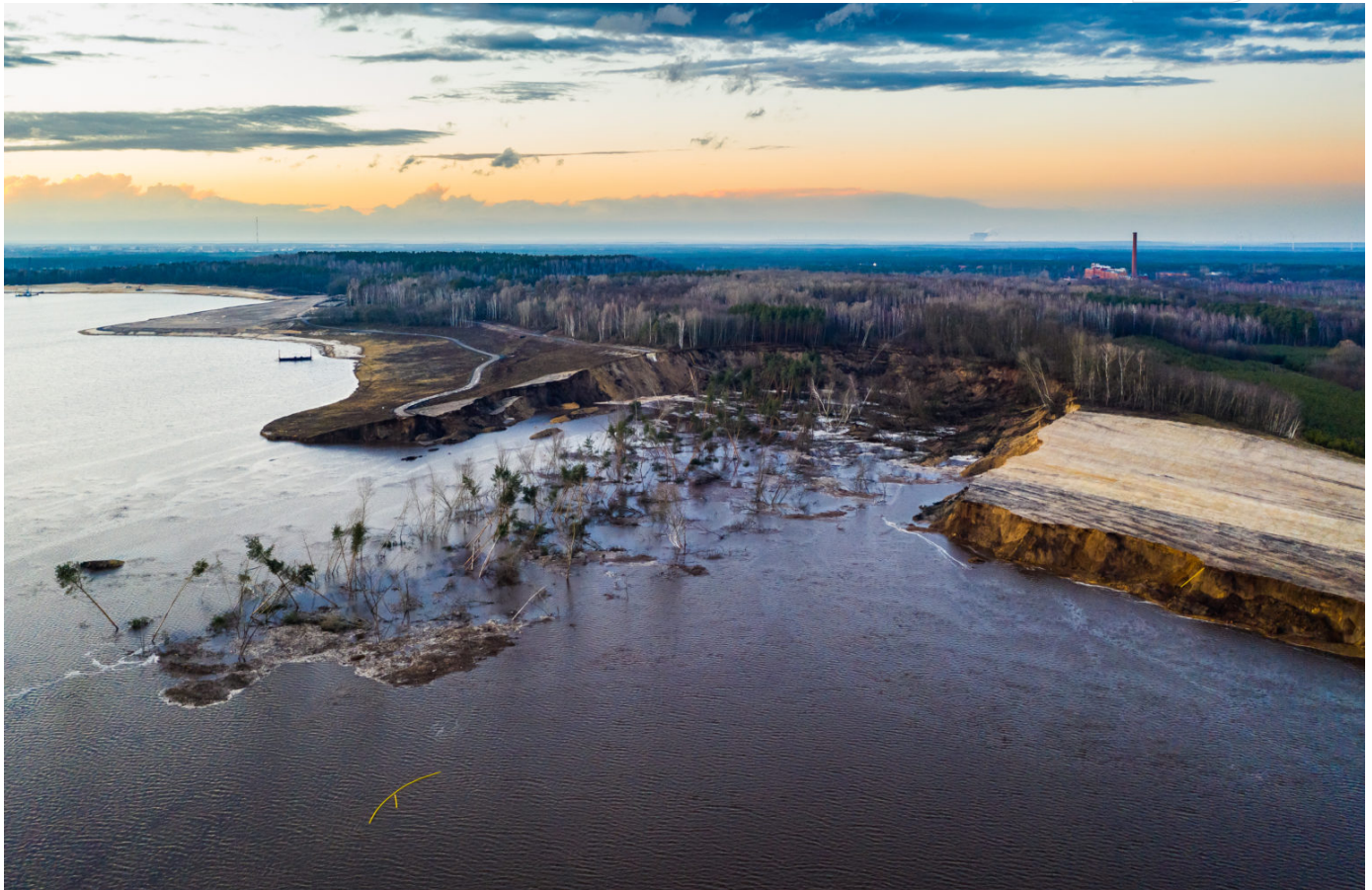
Rutschungskessel nach Setzungsfließen am Knappensee im März 2021
