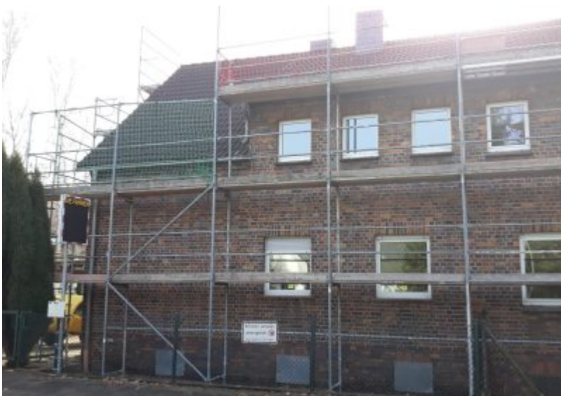
Vorbereitung einer Hausabtragung in Lauchhammer
