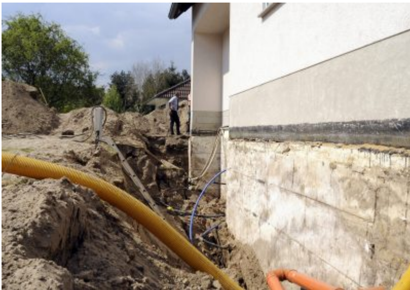
Hausanhebung zur Sicherung vor wieder ansteigendem Grundwasser
