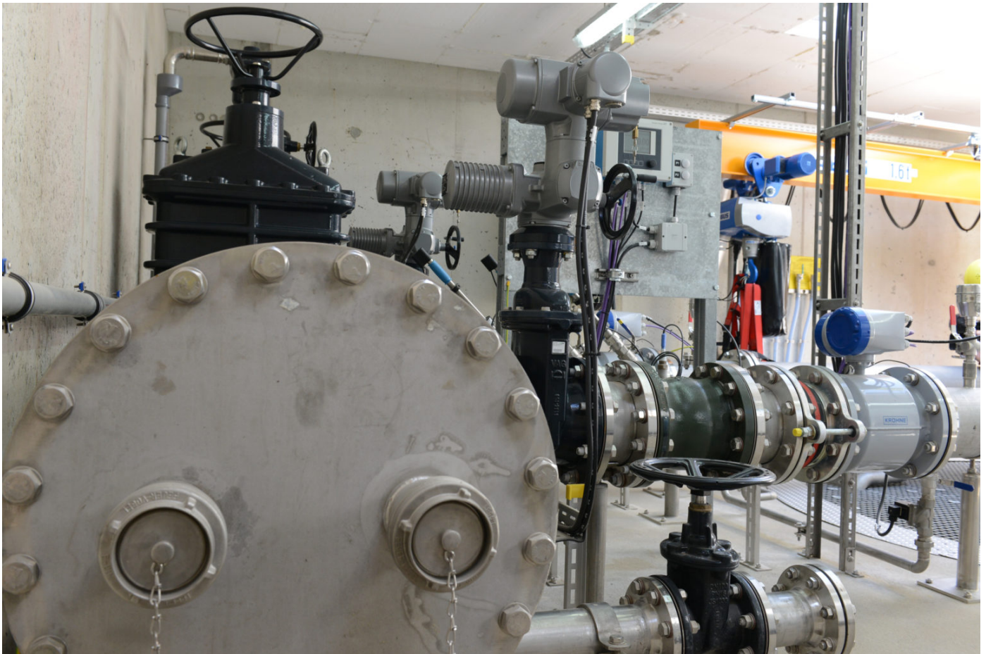
Errichten eines Horizontalfilterbrunnens
