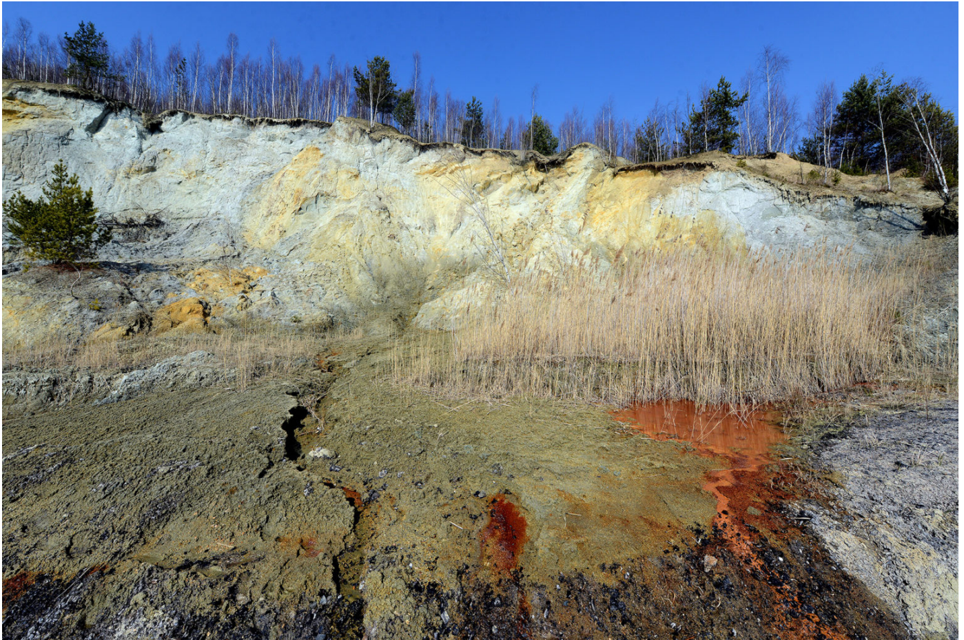
Sanierungsbereich Böschungsbewegung Nachterstedt
