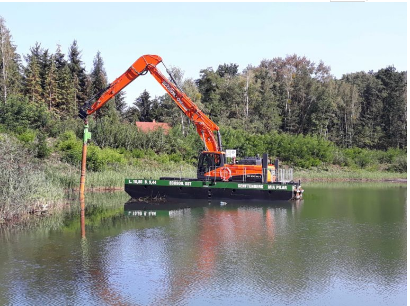
Mittels amphibischer Technik wird Neumanns Grube gesichert
