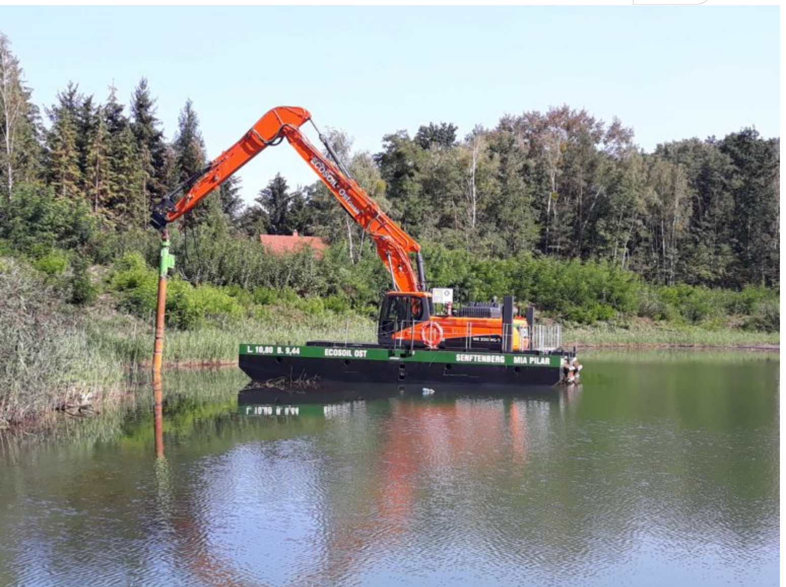
Mittels amphibischer Technik wird Neumanns Grube gesichert
