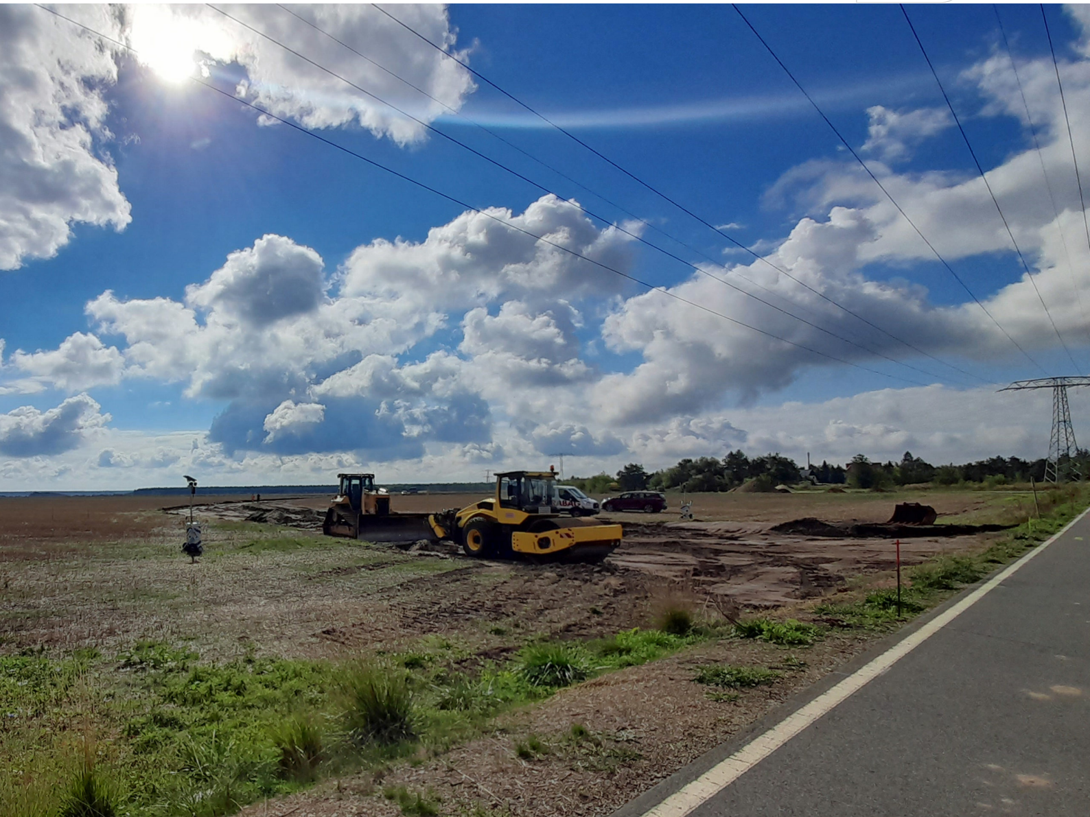
Bauzufahrt zur Brückenfeldkippe Sedlitz, Sep. 2022
