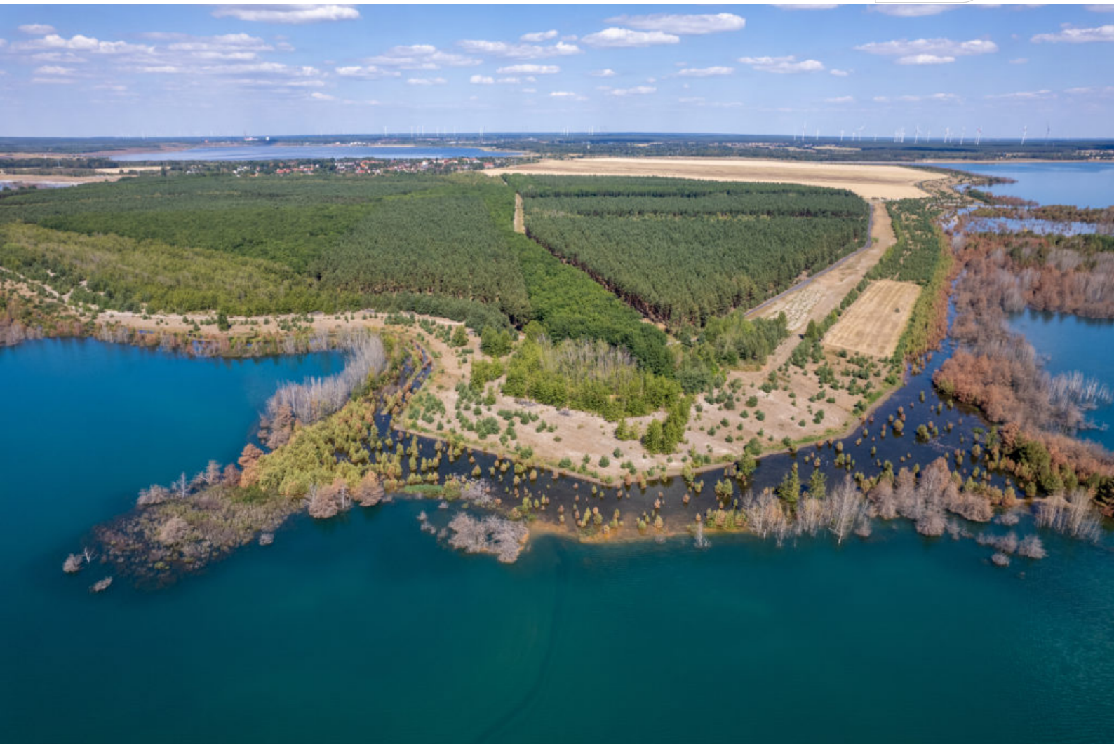
Brückenfeldkippe Sedlitz, August 2022
