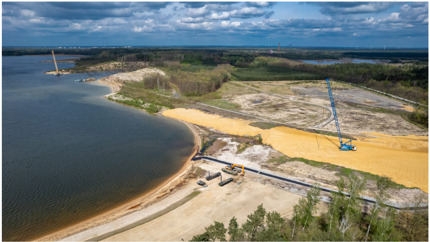
Sicherung am Koblenzer Graben und Rutschungskessel 2024
