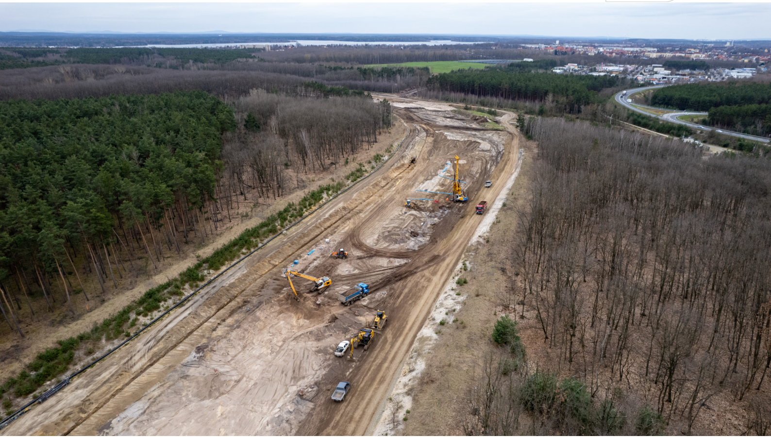
Blick auf die Baustelle Ableiter Sedlitz
