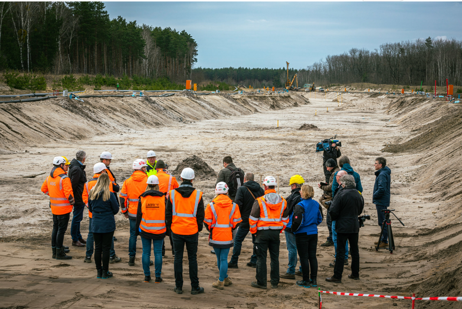
Großes Interesse am Spatenstich zum Bau des Ableiters
