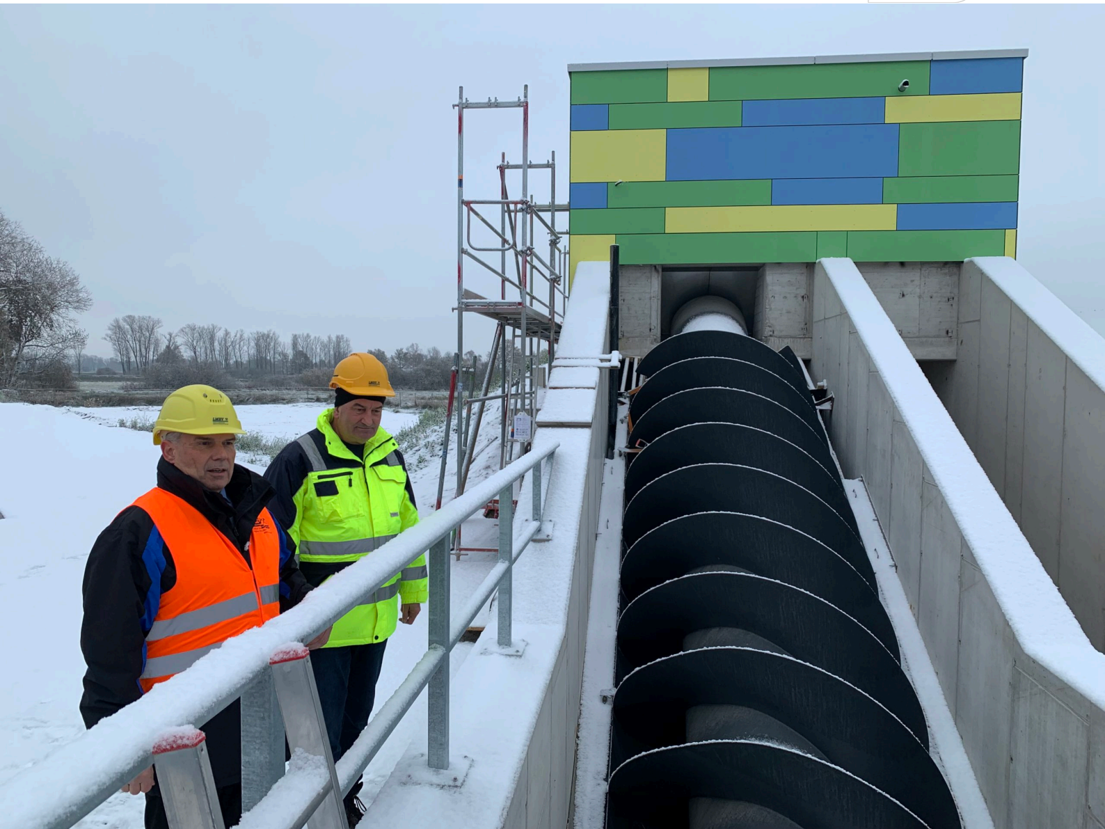
Am Turbinenhaus der WBA Plessa: Blick auf die Förderschnecke.
