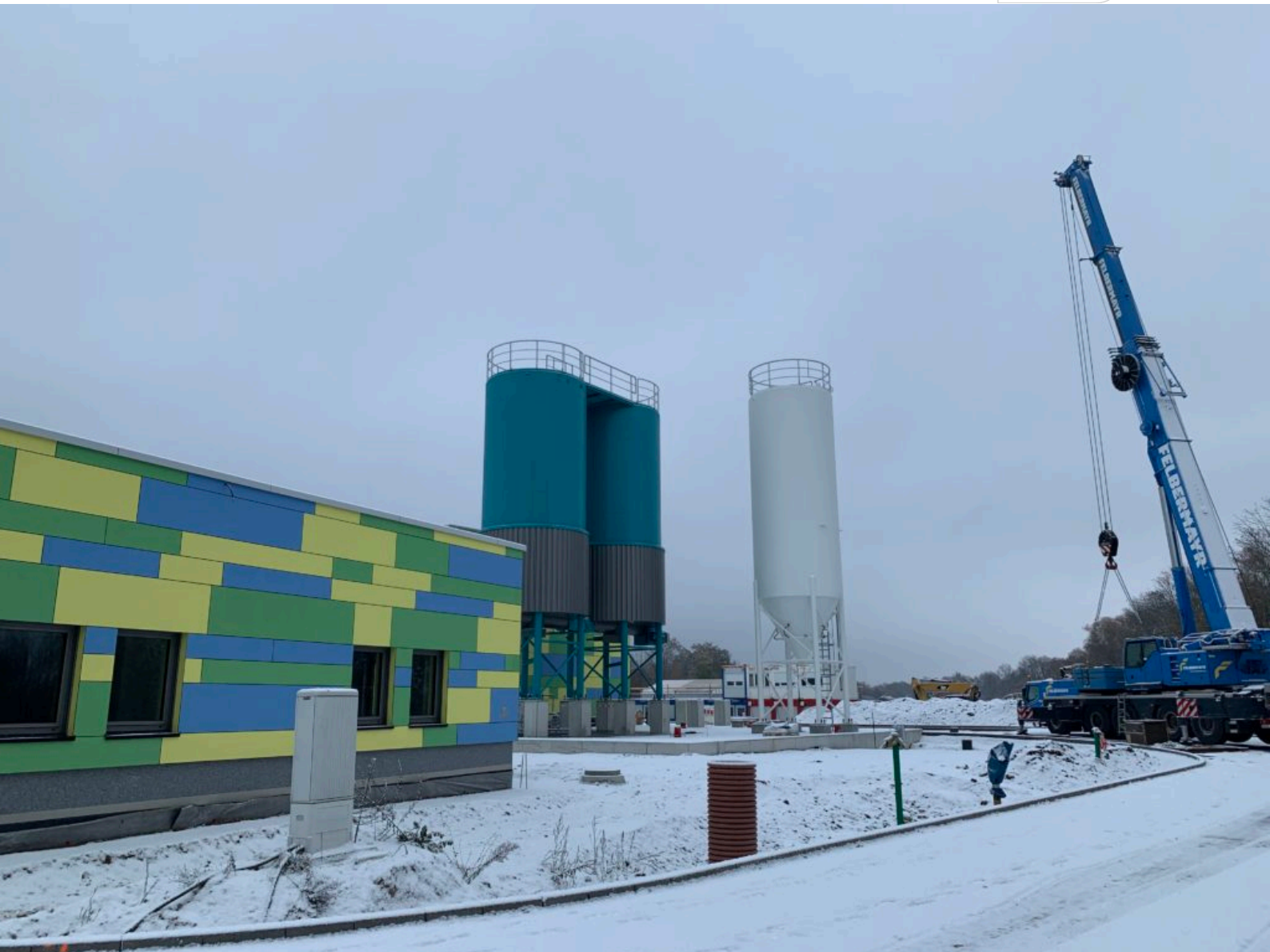
Der Kran wurde zum Aufstellen der Schlammsilos genutzt.
