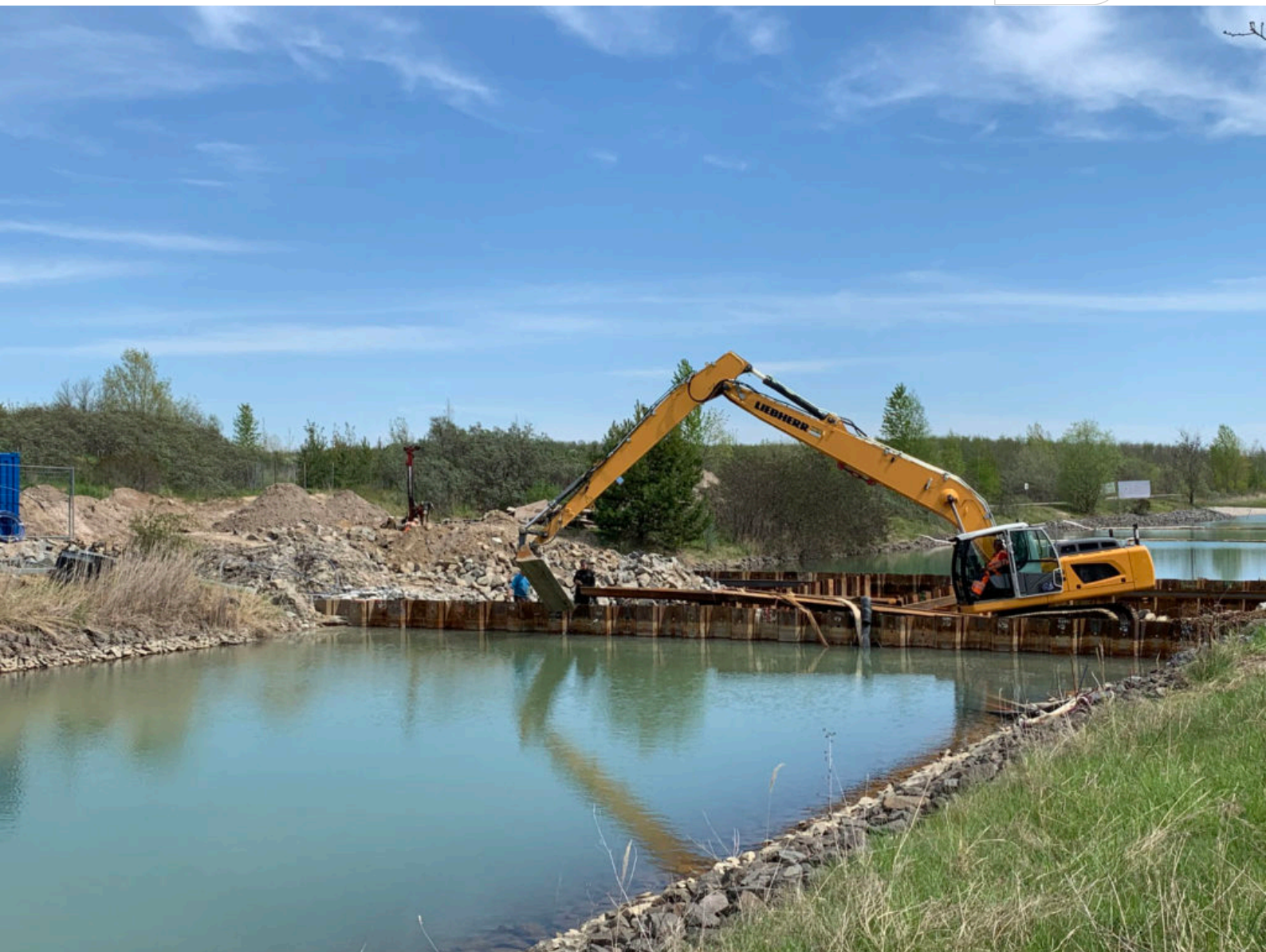
Auffüll- und Schweißarbeiten am Oberen Querbauwerk
