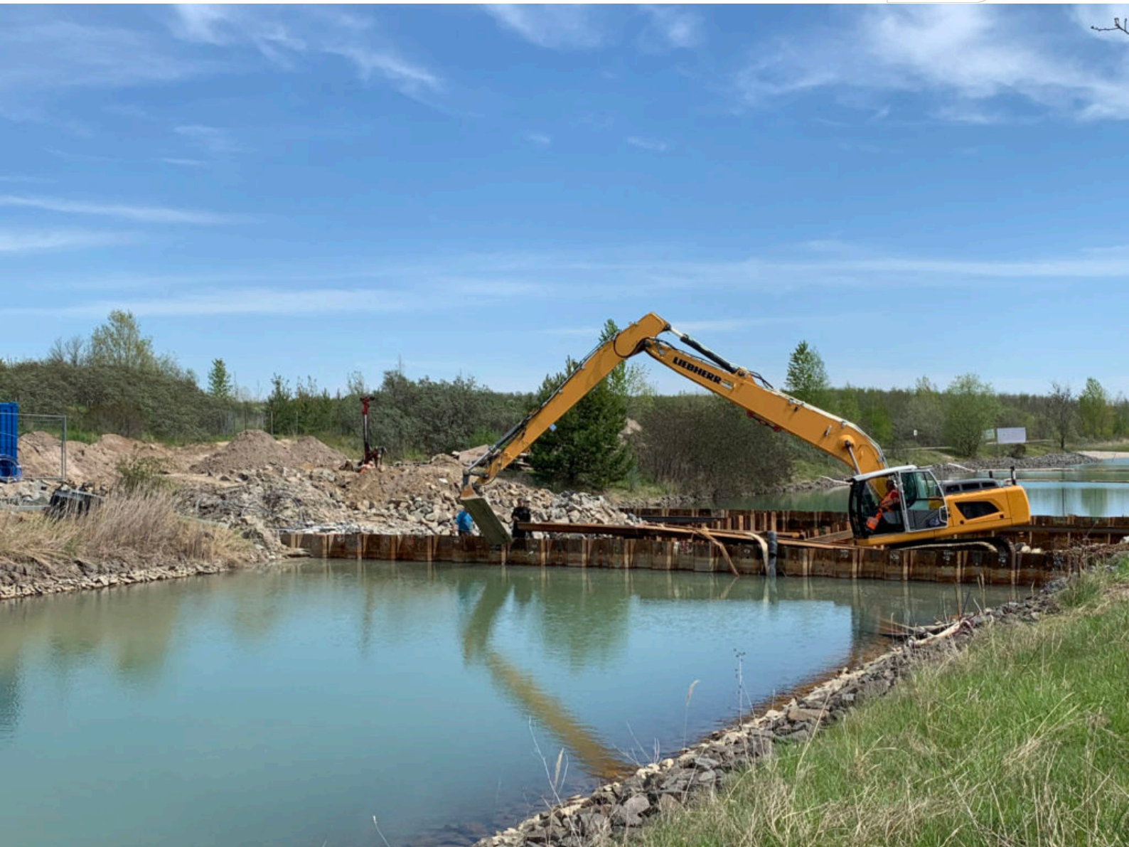
Auffüll- und Schweißarbeiten am Oberen Querbauwerk
