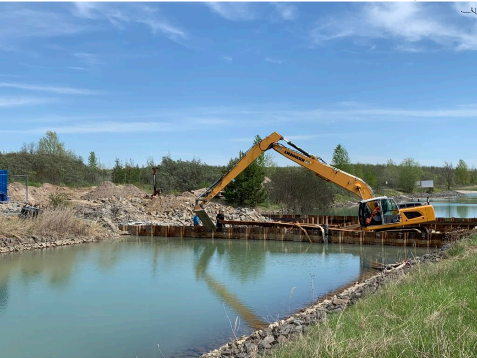
Auffüll- und Schweißarbeiten am Oberen Querbauwerk
